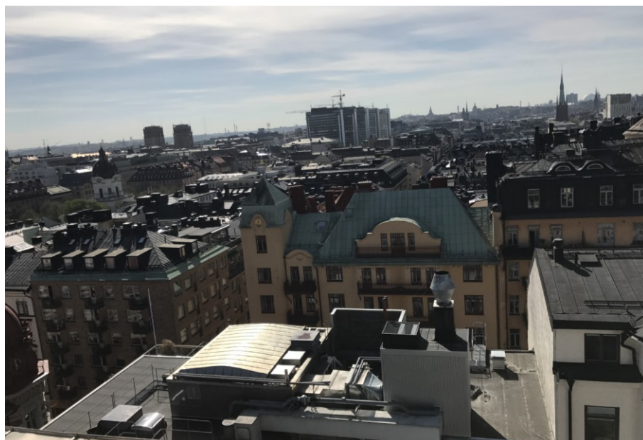
Figur 8 Taklandskapet, vy söder ut från planområdets tak. Närmast syns Strindbergsmuseets torn.
