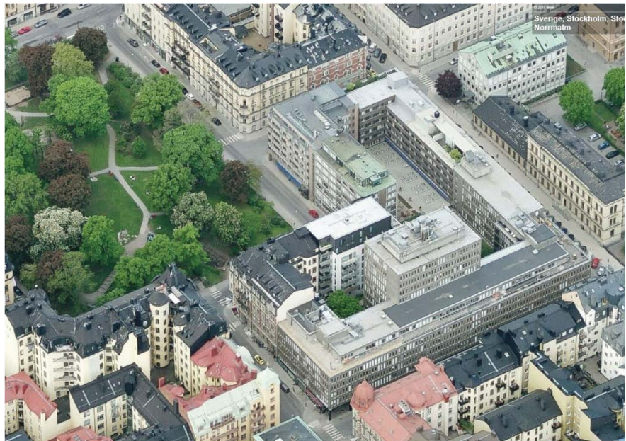
Befintliga situation med Tegnérunden till vänster i bild.
