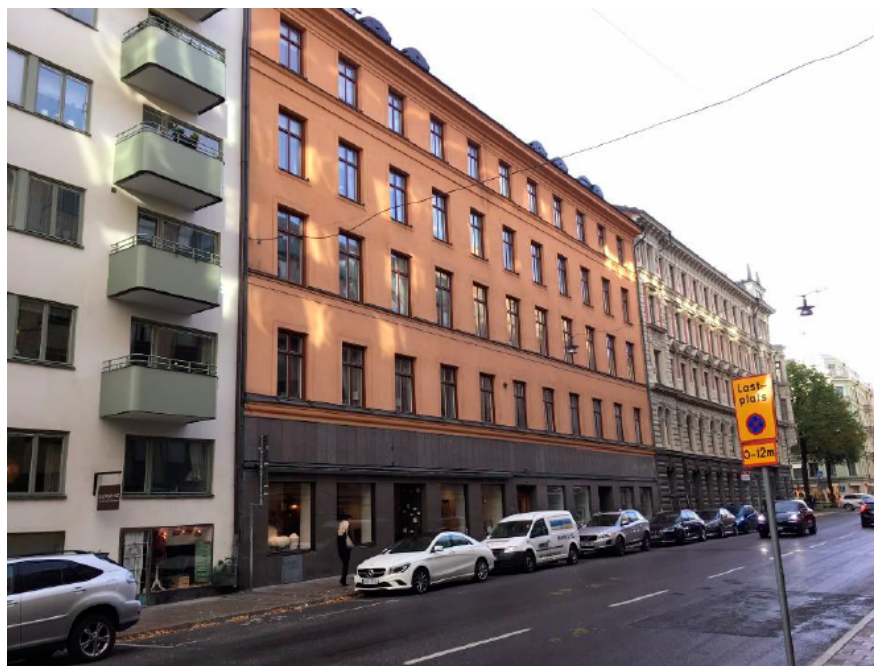
Fasad mot Söbyllegatan. Foto: Martin Wernersson WSP.
