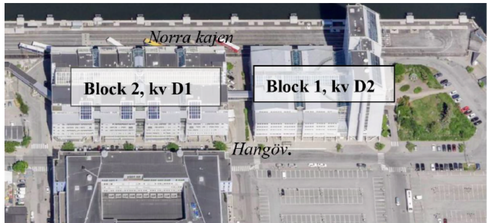
Flygbild mot norr som visar befintlig byggnad inom fastigheten.
