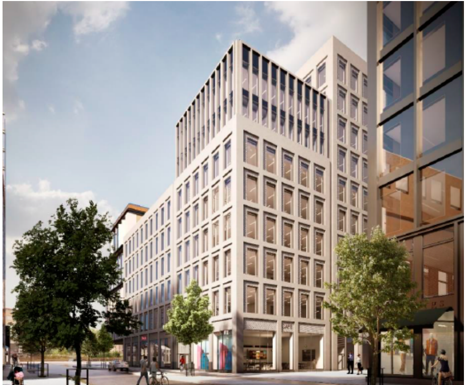
Vy mot väster längst Hangövägen. Byggnad i kvarteret Hangö, A2 på plankartan. Bilden visar hur hörnets övre våningar skiljer sig i utformning för att tydliggöra gatans sexvåningskala enligt med planbestämmelse fl. Illustration Brunnberg Forshed.
