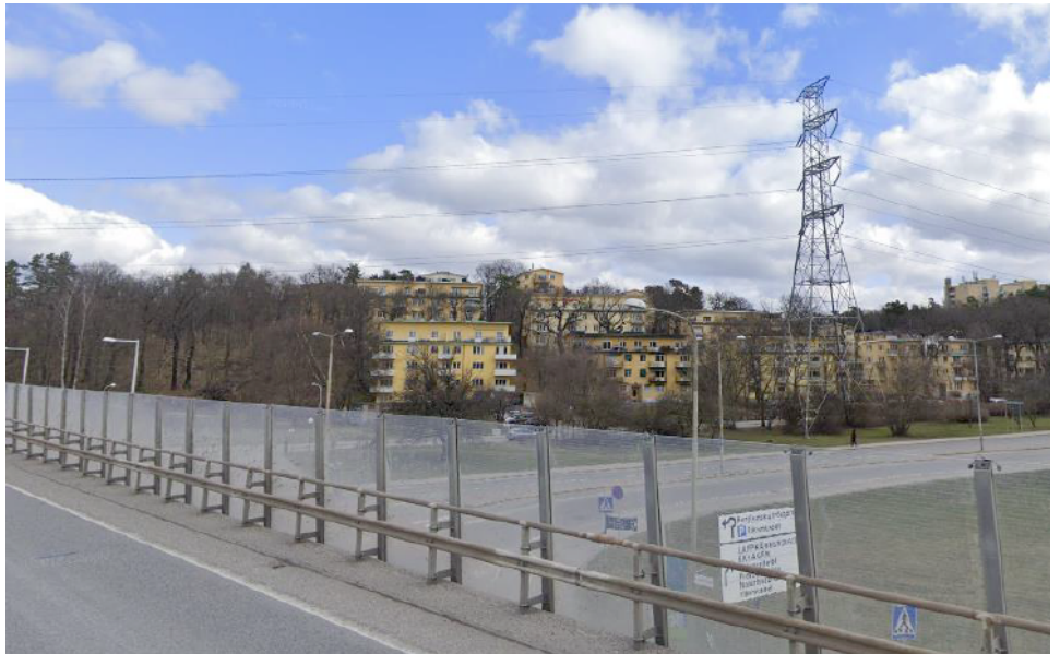
Stolpe nr 544 vid Bergiusvägen och bostadsområdet Ekhagen. Stolpen kommer ersättas av två kabeländstolpar närmare Norrtäljevägen. Foto Google Maps.
