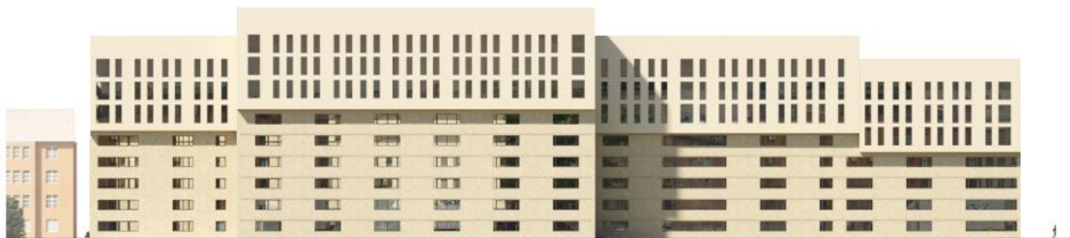
Fasad mot nordost. Hus C
