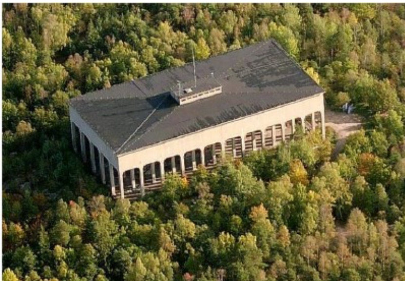
Den befintliga Uggleviksreservoaren på Kattrumpsbackens topp i Lill-Jansskogen. Ritad av arkitekten Paul Hedqvist och togs i drift 1935.
