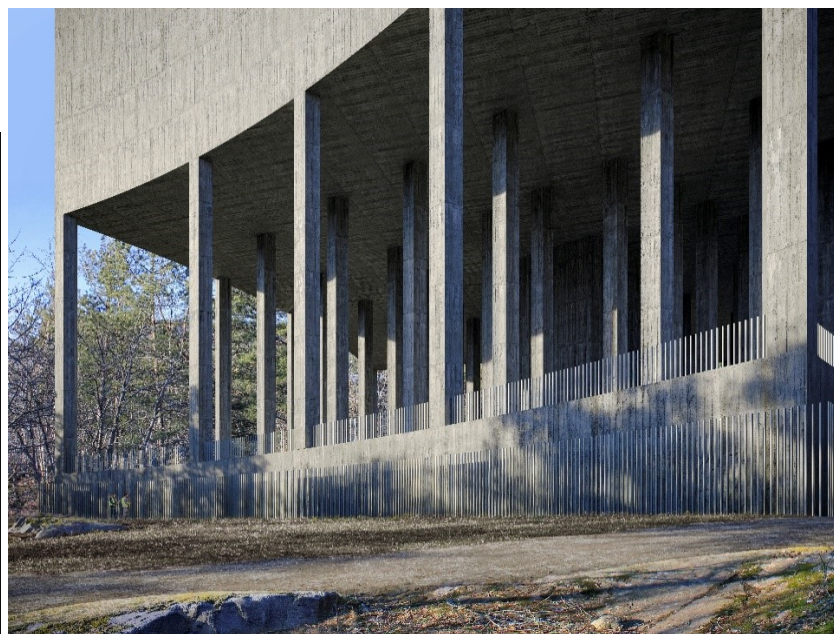
Staketet utformas med vertikala rör av rostfritt stål utan synligt fundament. Fallskydd i pelarsalen ges en utformning lika skalskyddet. Serviceytan närmast byggnaden utförs växtbeklädd.
