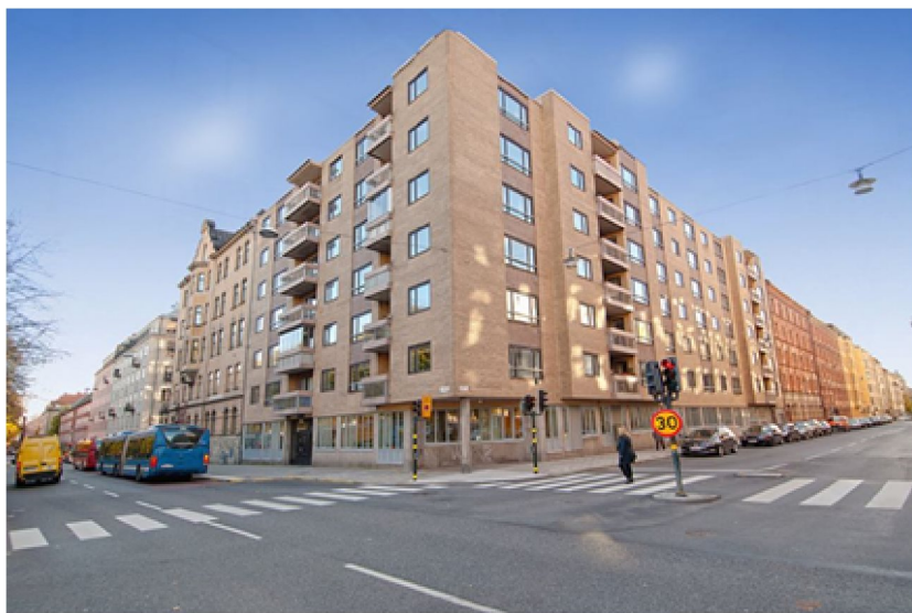
Foto som visar bostadshuset inom fastigheten Storken 13. Vy från korsningen Valhallavägen (till vänster)/Sibyllegatan (till höger).
