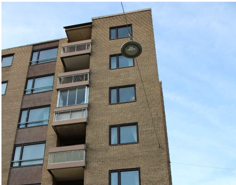
Foto som visar del av byggnadens fasad med balkonger som delvis inglasats och fått nya fronter.
