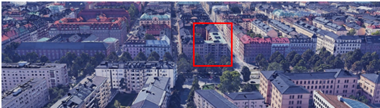
Flygfoto som visar Valhallavägens södra fasad front. Fastigheten Storken 13 ligger inom röd linje.
