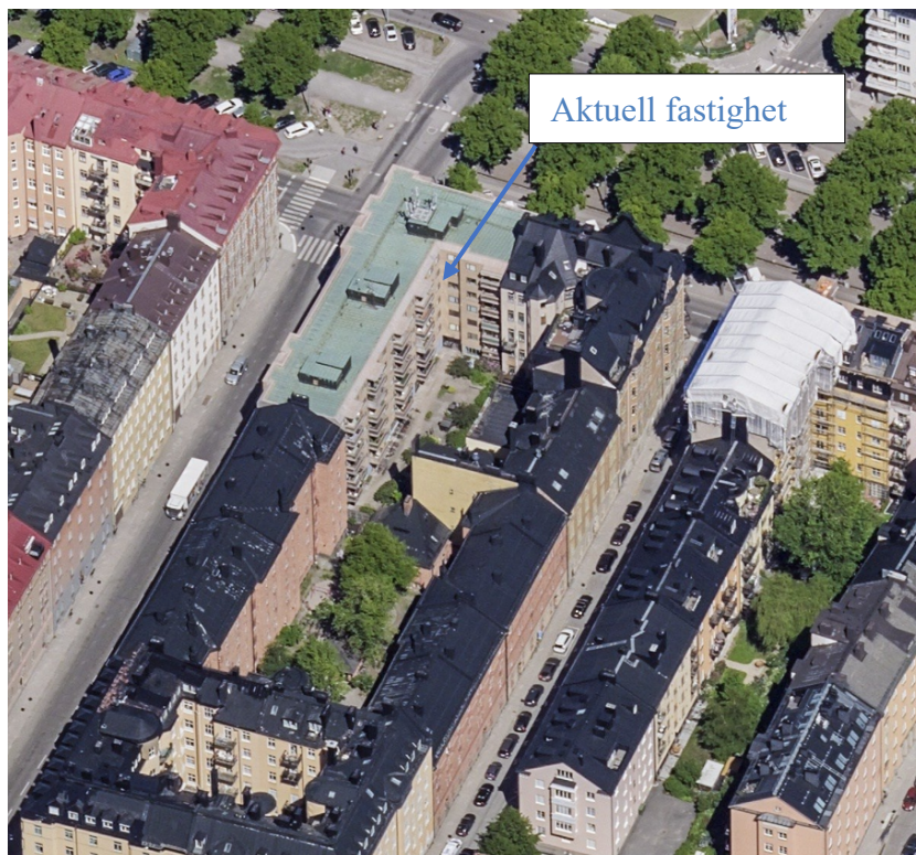
Flyg vy som visar fastighetens befintliga tak från söder. Vy mot norr.
