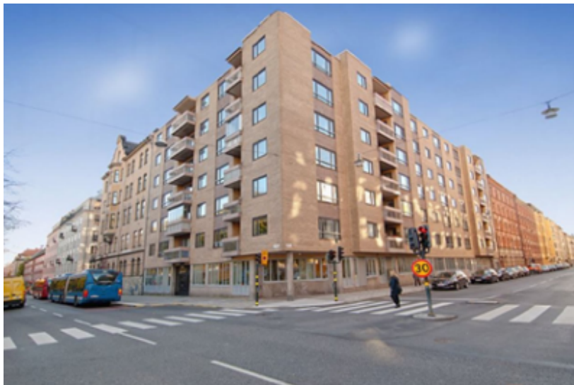
Foto som visar bostadshuset inom fastigheten Storken 13. Vy från korsningen Valhallavägen (till vänster)/Sibyllegatan (till höger).
