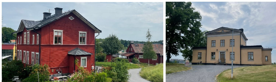
Bostället och Gamla Dockmästarbostaden i bilden till vänster. Dockmästarbostaden den så kallade Stenvillan i bilden till höger. Källa: Sweco
