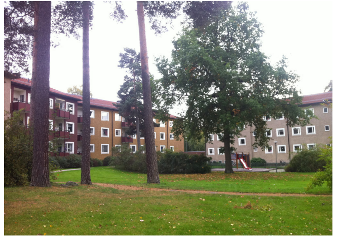
Karaktäristiskt grupperade smalhus runt stora gårdsrum med sparad naturmark i Blackeberg.
