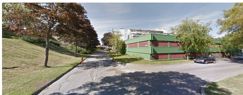
Trondheimsgatan - avsaknad av både entréer, butiker och gångbanor. Garagens (i grönt) närmaste del avses rivas och ersättas av ett fem våningar högt bostadshus.
