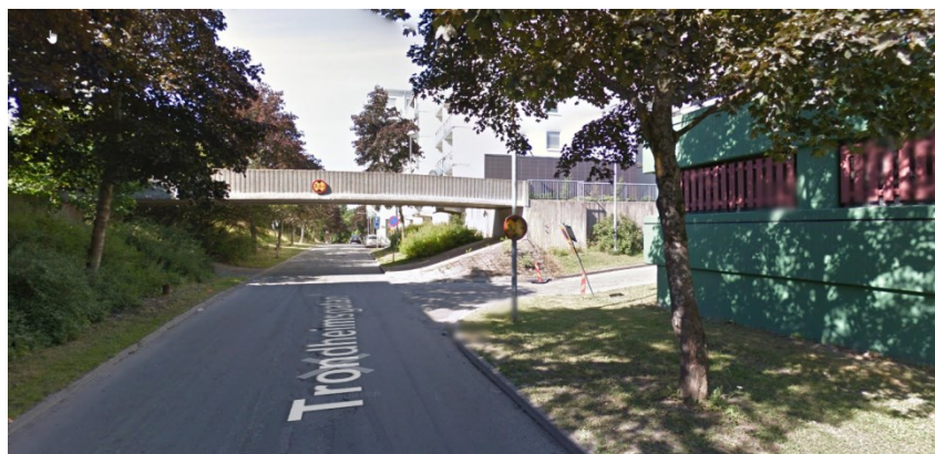
Tydlig trafikseparering genom gångbro.
