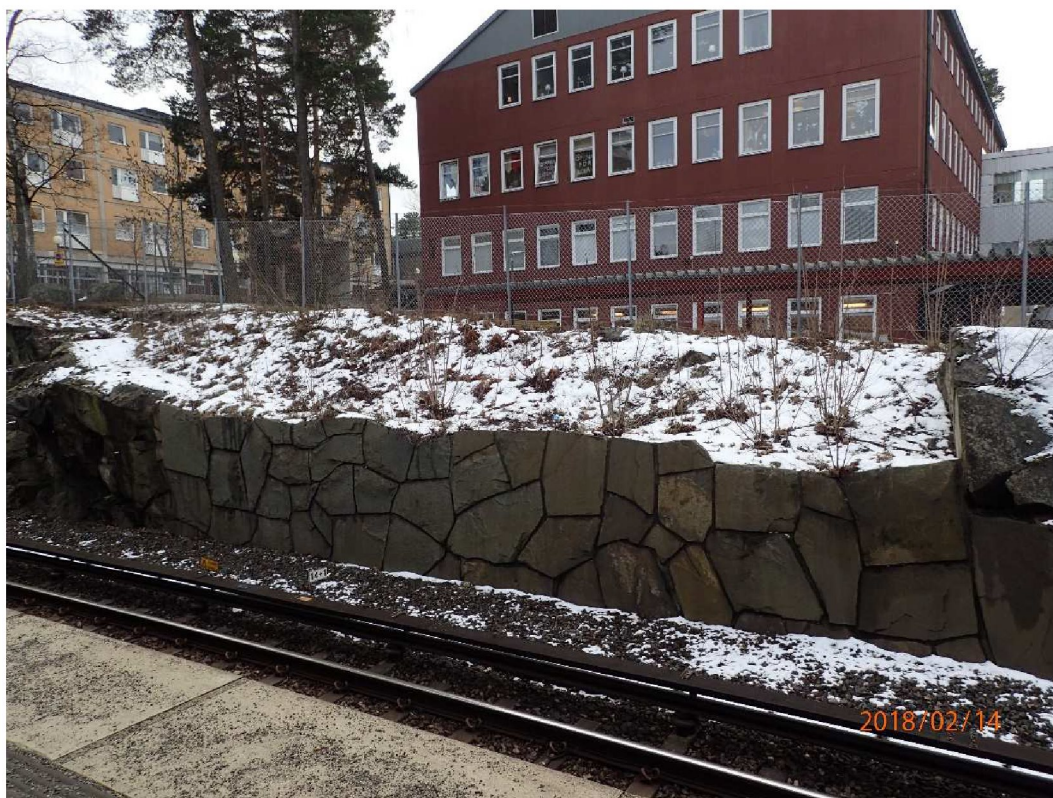
Figur 3.6. Ett dåligt parti berg har rensats bort och en stödmur har byggts. Bakom stödmuren har man fyllt upp med lösa massor.
