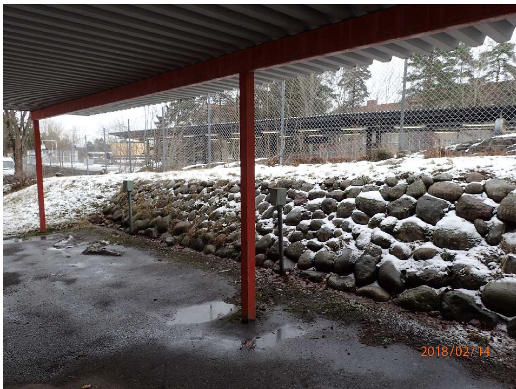
Figur 3.11. Det finns en slänt som är förstärkt med stenar. På andra sidan staketet finns stödmuren.
