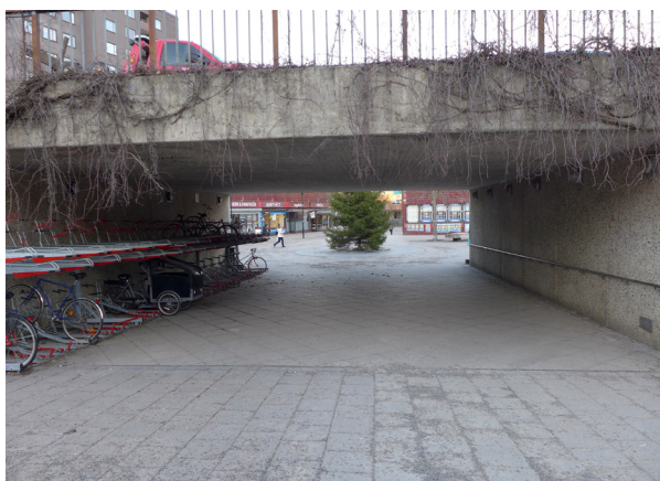
Fotografier från ovan vänster: Lokatten 1 med utbyggnad, mot sydväst. Parkeringsyta öster om torget, foto mot öster. Entréer på Lokatten 1, ursprungligt på västfasaden samt flyttat dörrläge för ICA. Viadukten mellan torget och tunnelbanestationen under Selmedalsvägen, samt trappa från vägen ner till Hägerstens torg.
