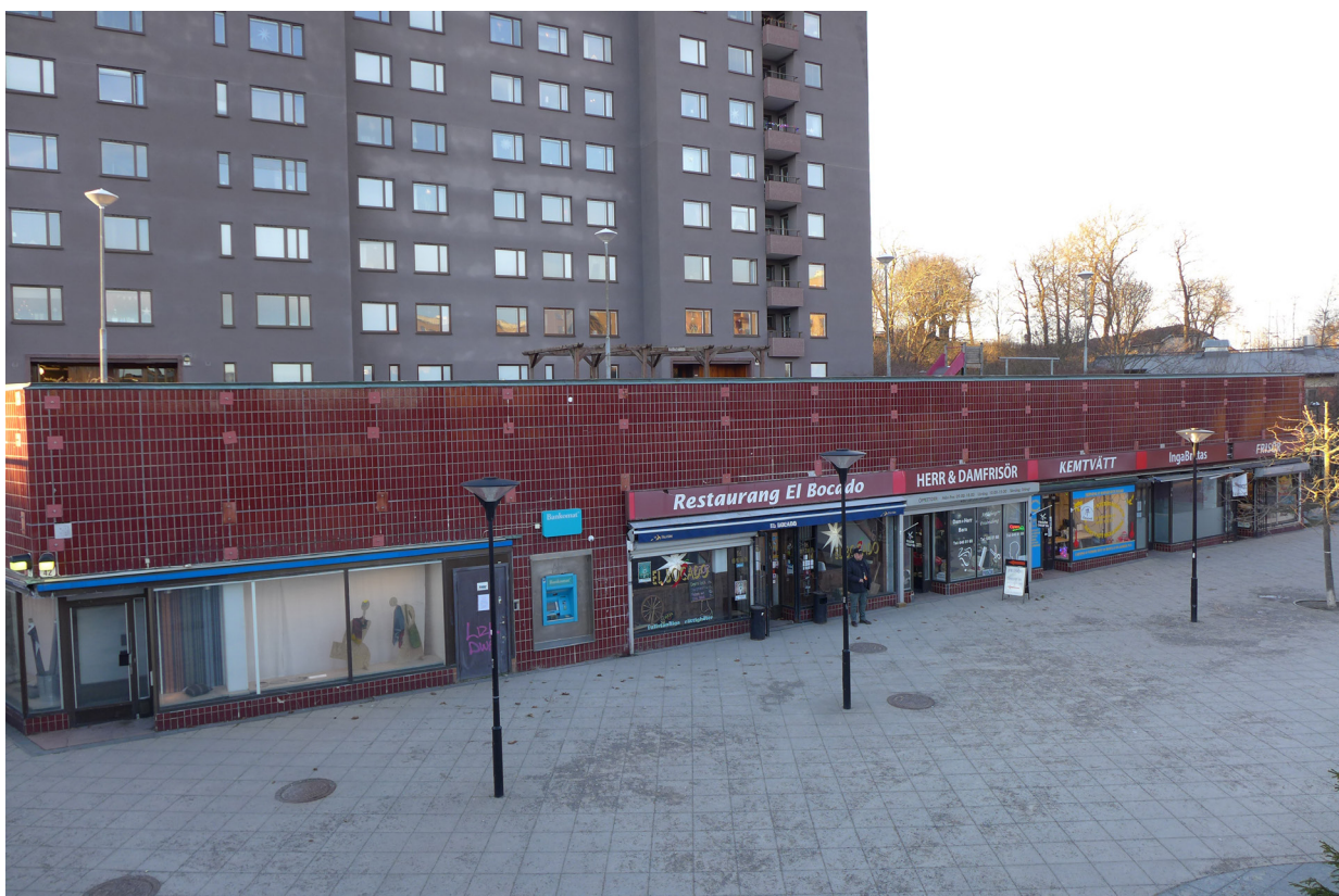
Centrumbyggnaden i Förgyllda bågaren 8. Foto mot nordväst.
