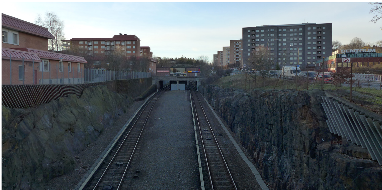
Tunnelbanespåren som går parallellt med Selmedalsvägen och torget. Till höger skymtar Hägerstens torg. Bilden illustrerar områdets olika bebyggelseskalar. Foto mot väster.
