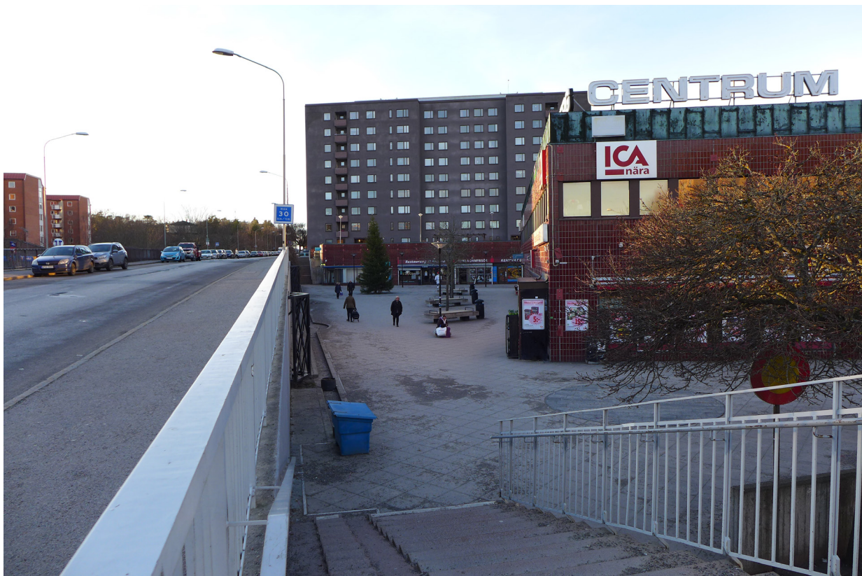
Översikt mot väster med Selmedalsgatan till vänster i bild och det lågt belägna torget till höger.
