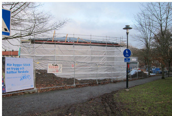
Figur 48. Pågående arbete med uppförande av ny förskola i närheten av Hägerstenshamnen.
