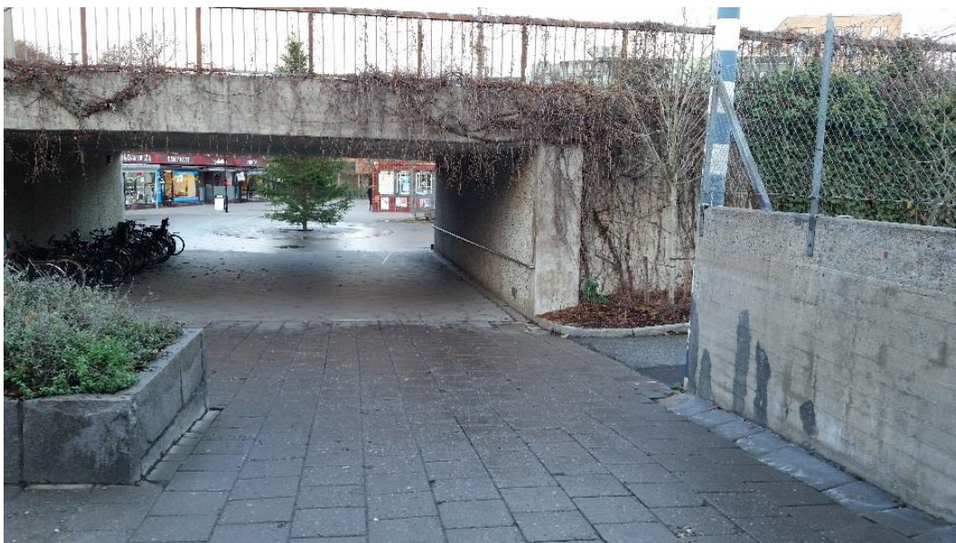
Figur 2. Tunnel under Selmedalsvägen till torget sett från tunnelbanestationen.
