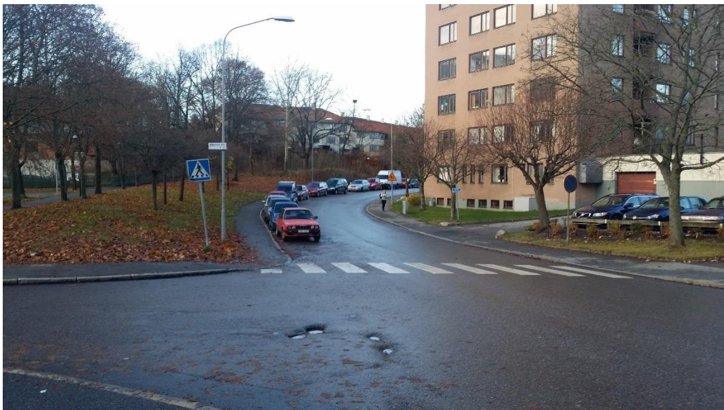
Figur 14. Hägerstens allé som svänger av mot norr bakom Axelsbergs centrum och infart till vändplan bakom centrum till vänster i bilden. Lågpunkt ungefär vid den röda bilen.
