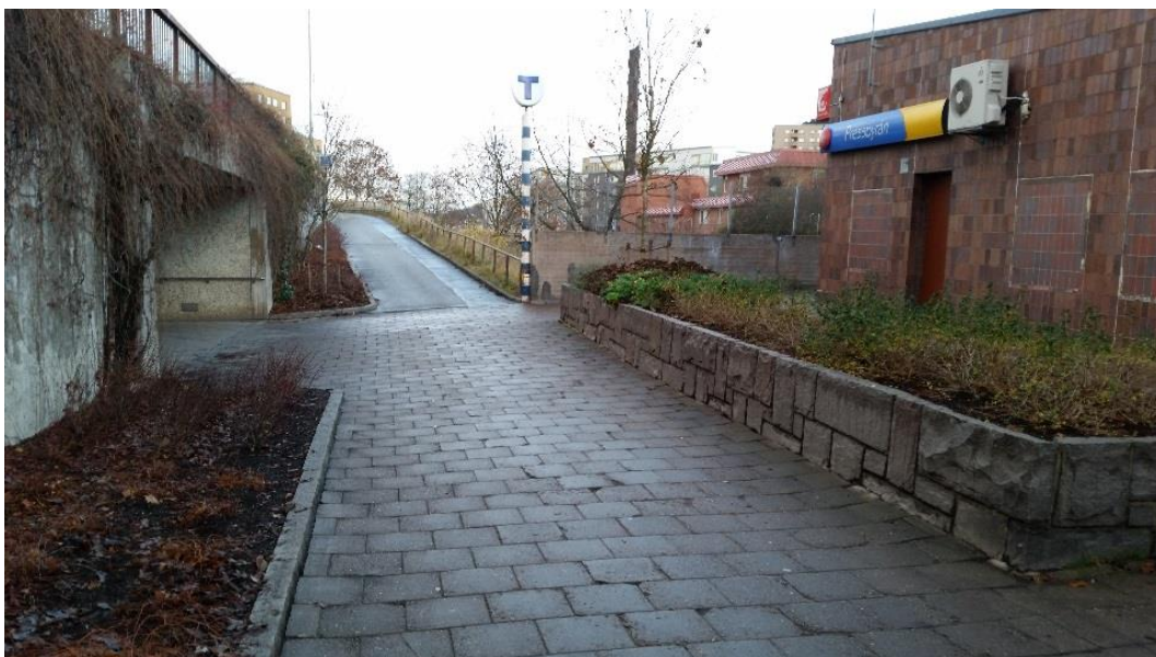
Figur 15. Tunnelbanestation till höger och tunnel under Selmedalsvägen till torget åt vänster.
