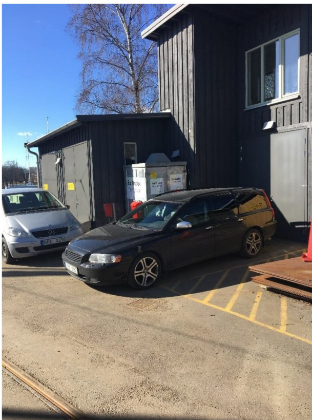
Dagvattenbrunn i lågpunkt på Falkenbergsgatan.
