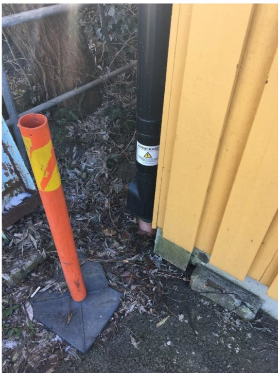
Stuprör som går ner i mark.
