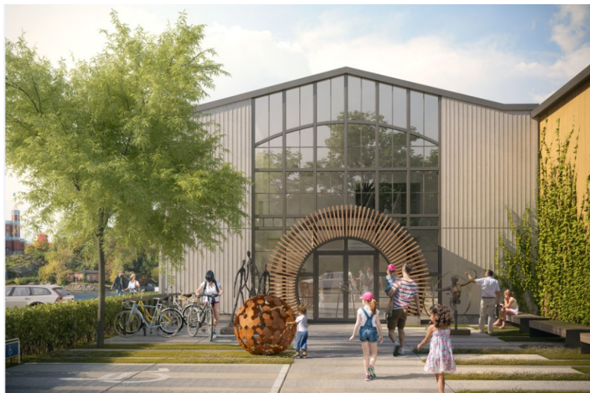
Fasad "Ferdinand" mot nordost (mot Falkenbergsgatan) föreslås utföras i stål och glas i mittpartiet och träpanel på sidorna. Entrén som föreslås är en båge i stål som liknar den välva entré som Bobergs maskinhall hade.
