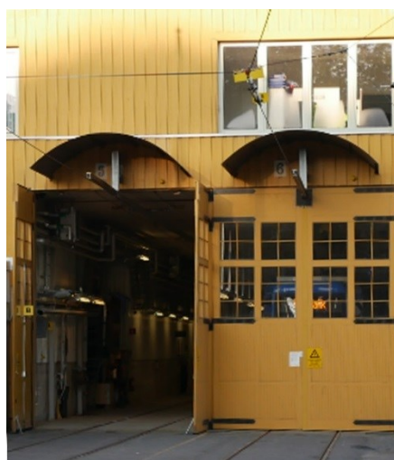
Befintlig fasad på Spårvagnshallen mot Falkenbergsgatan
