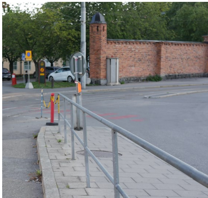
Befintlig refug med stålräcke i Falkenbergsgatan och tegelmur i bakgrunden.
