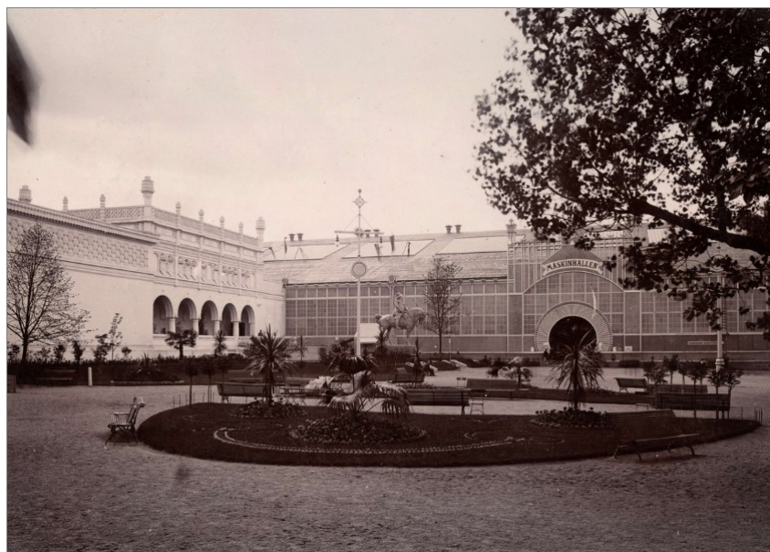
Maskinhallen från 1897 ritad av Ferdinand Boberg.
