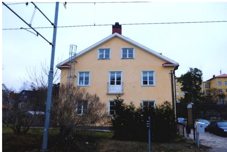
Bostadshusets gavel sedd från spårvagnsstationen.
