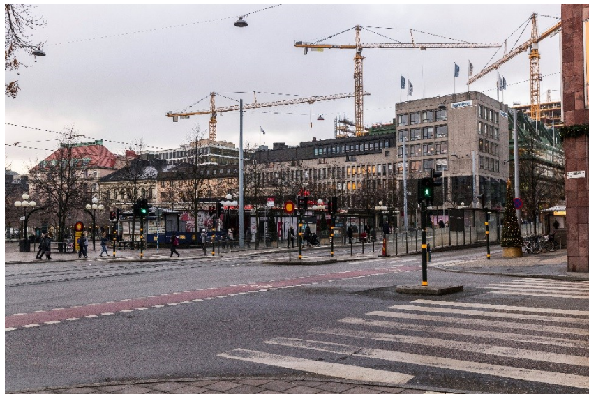
Fastigheten Sju Sekel 1 sedd från korsningen Hamngatan/ Norrländsgatan. Källa: Stadsbyggnadskontoret
