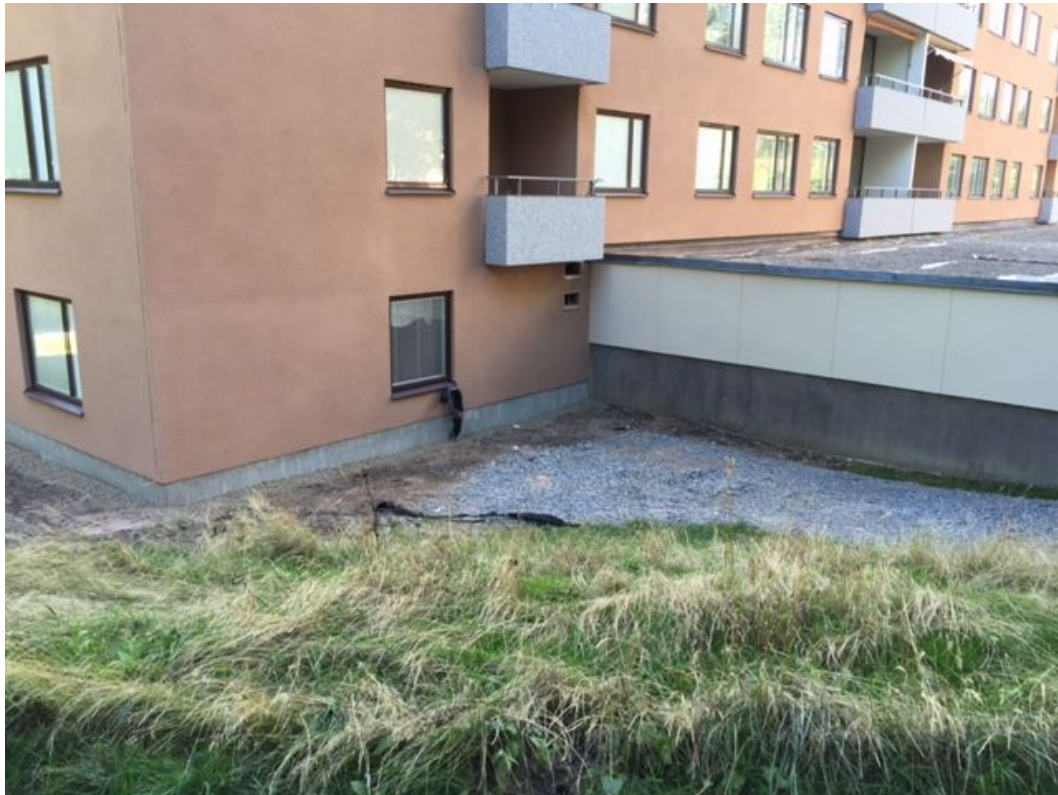
Figur 5.3: Odränerad och isolerad grund på fastighet mot Selmedalsvägen
