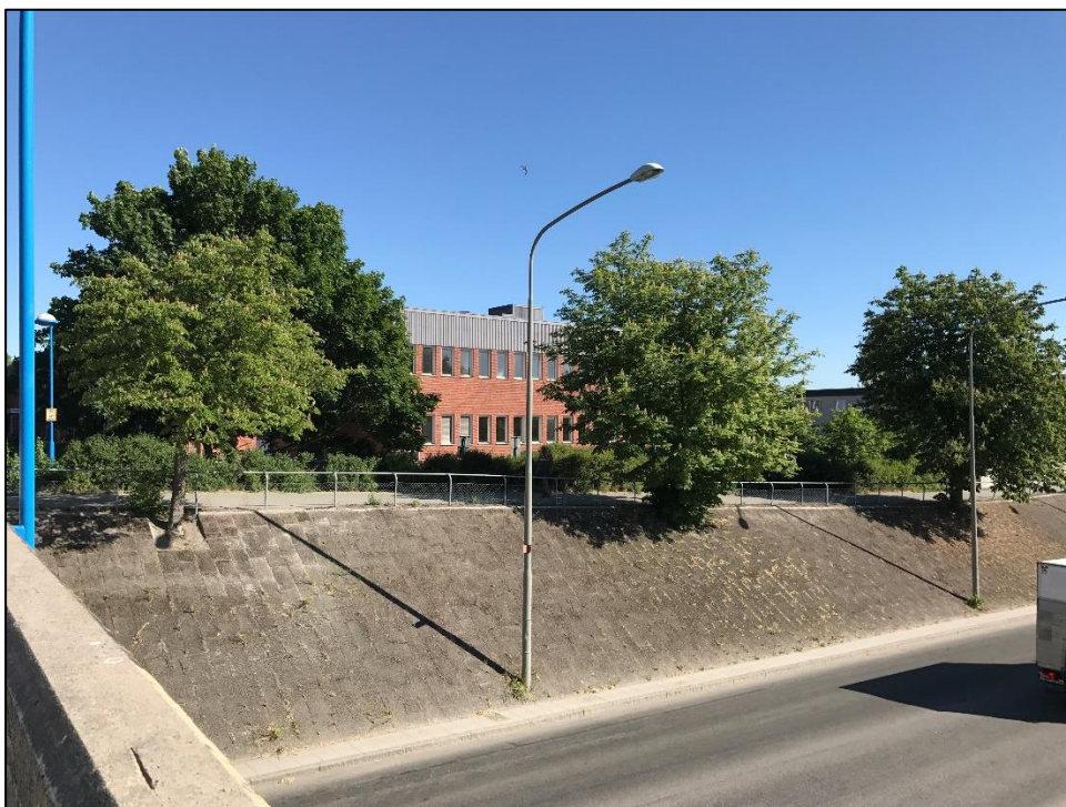
Figur 8. Stenlagd slänt mot Tenstastråket (vy mot öst)
