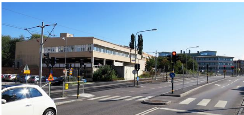
Befintlig kontorsbyggnad på Masugnen 5.
