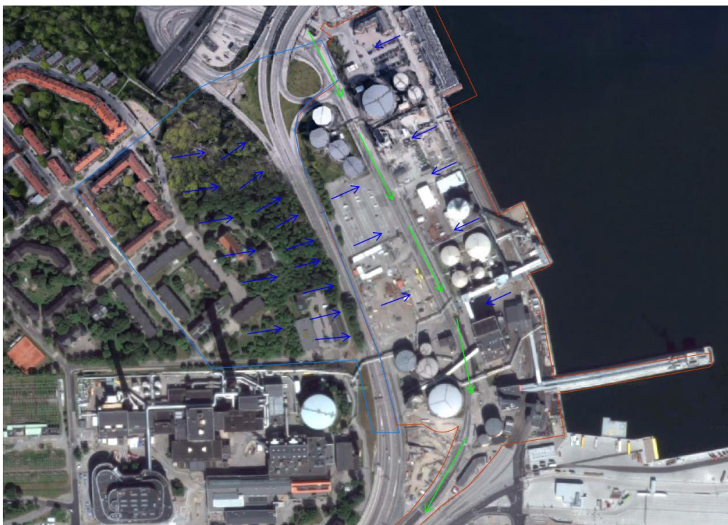
Figur 15 – Ytliga avvattningsvägar markerade på ett flygfoto. Blå pil markerar ytlig avrinning och grön pil ledningsbunden avrinning. Planområdet markeras med röd linje medan blå linje indikerar tillkommande avrinningsområde vid skyfall.
