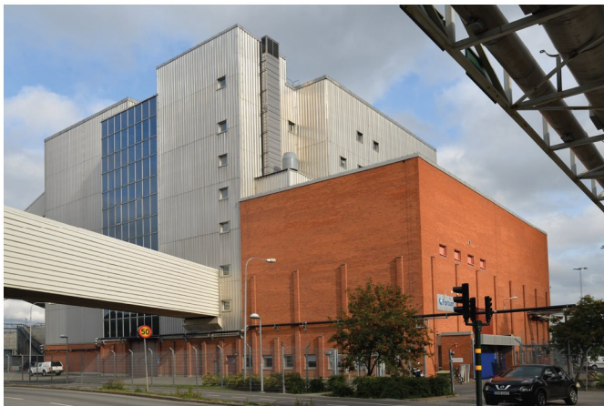
BILD 5:1:1:5 Byggnad för kolpreparering
