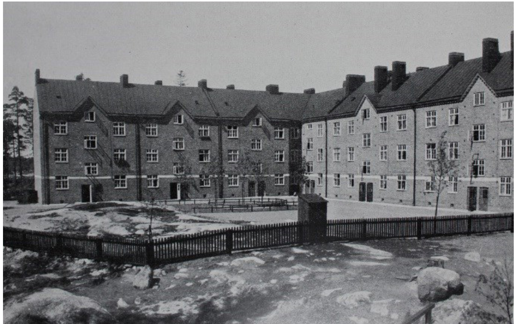
De första arbetarkasernerna från 1909. Bildkälla: Stockholmskällan.
