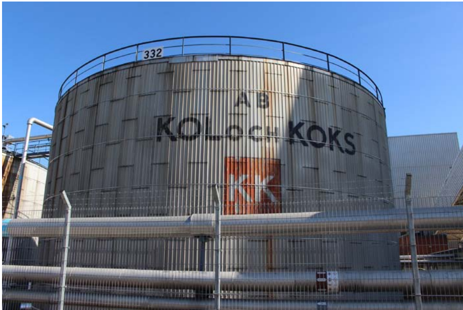
Cisternerna uppfördes av AB Kol- & koks som etablerade sig i Energihamnen i början av 1900-talet.
