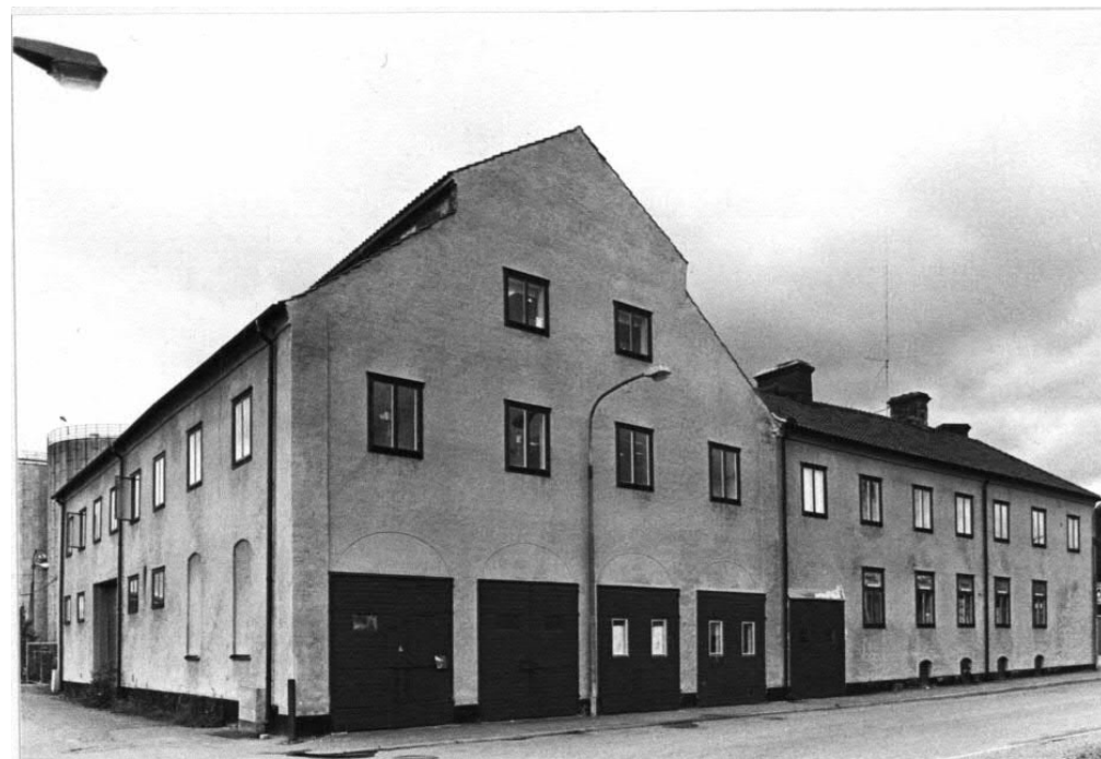
Kontors-/administrationsbyggnad i kv. Shanghai i slutet av 1980-talet, idag rivna. Källa: Foto hämtat från Stadsmuseets inventering av Värtahamnen, 1986.
