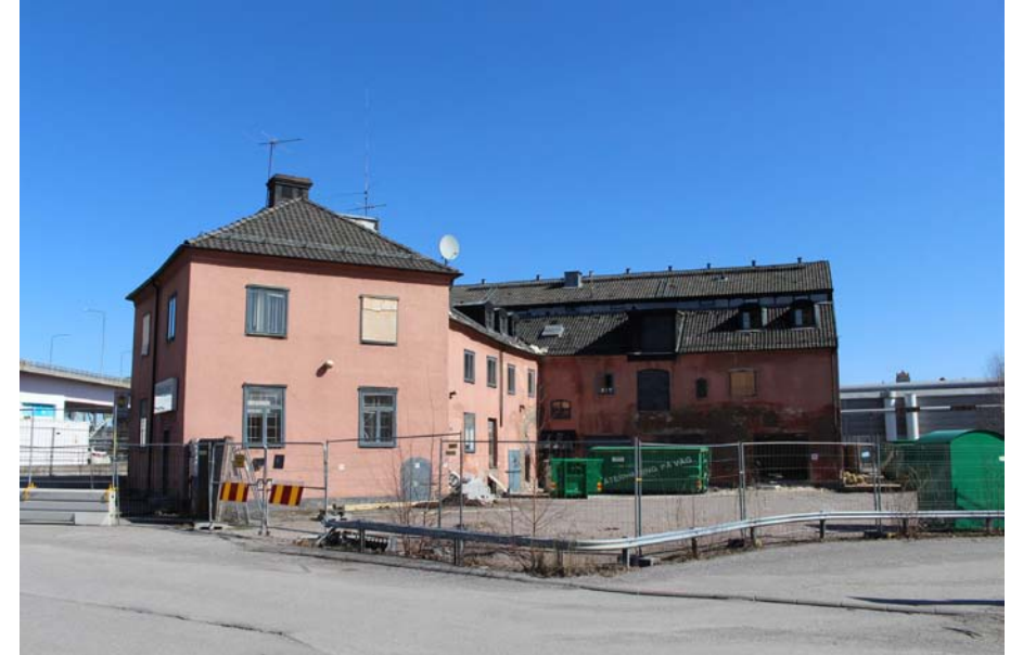
Före detta administrationsbyggnad i kvarteret Shanghai i planrådets norra del. Byggnaden uppfördes på 1920-talet av AB Kol & Koks. Rivningslov gavs i oktober 2017 och byggnaden revs i juni 2018.
