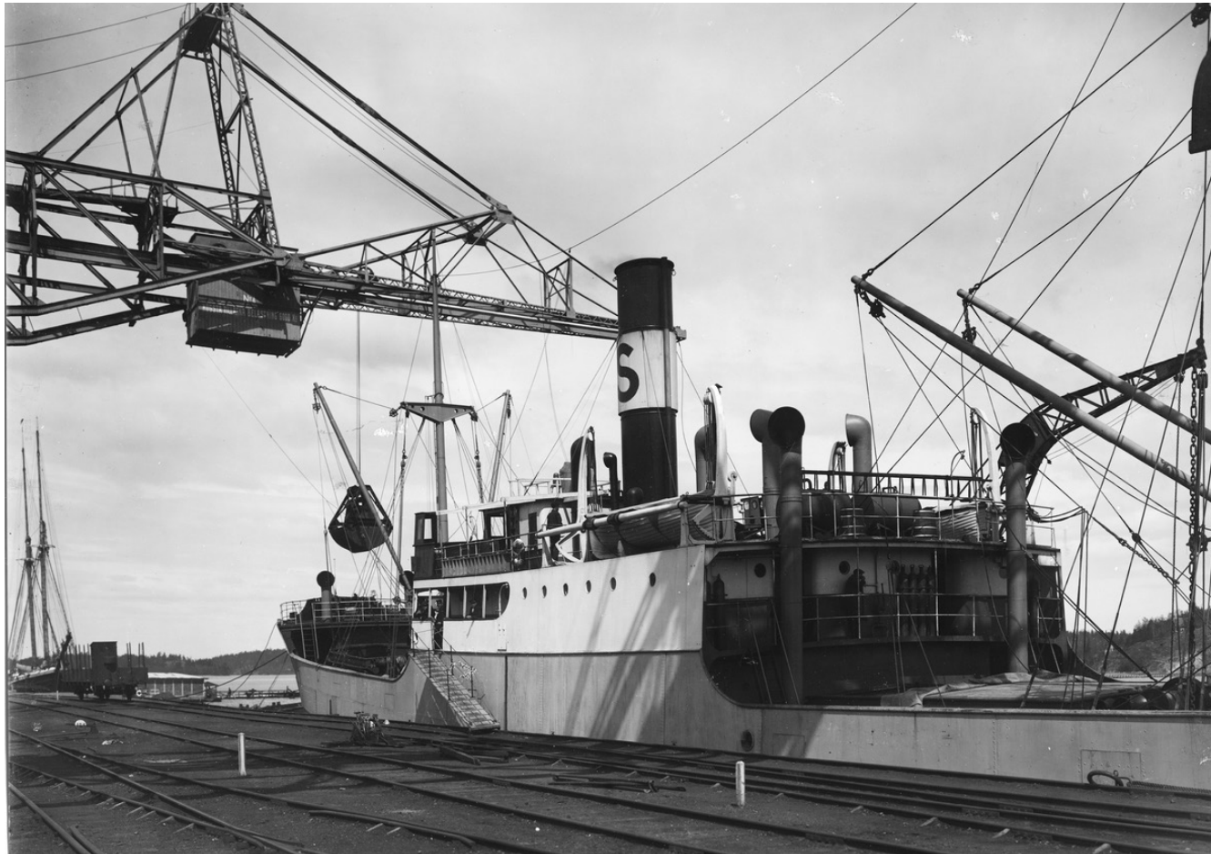
Lastanordning vid A.B. Kol och koks anläggningar i Värtahamnen, 1930. Järnvägsspåren för Värtabanan går längs med kajen. Källa: Tekniska museet (Digitalt museum)
