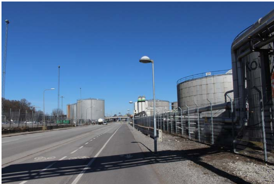
Norra Hamnvägen söderifrån med cisterner på var sida.
