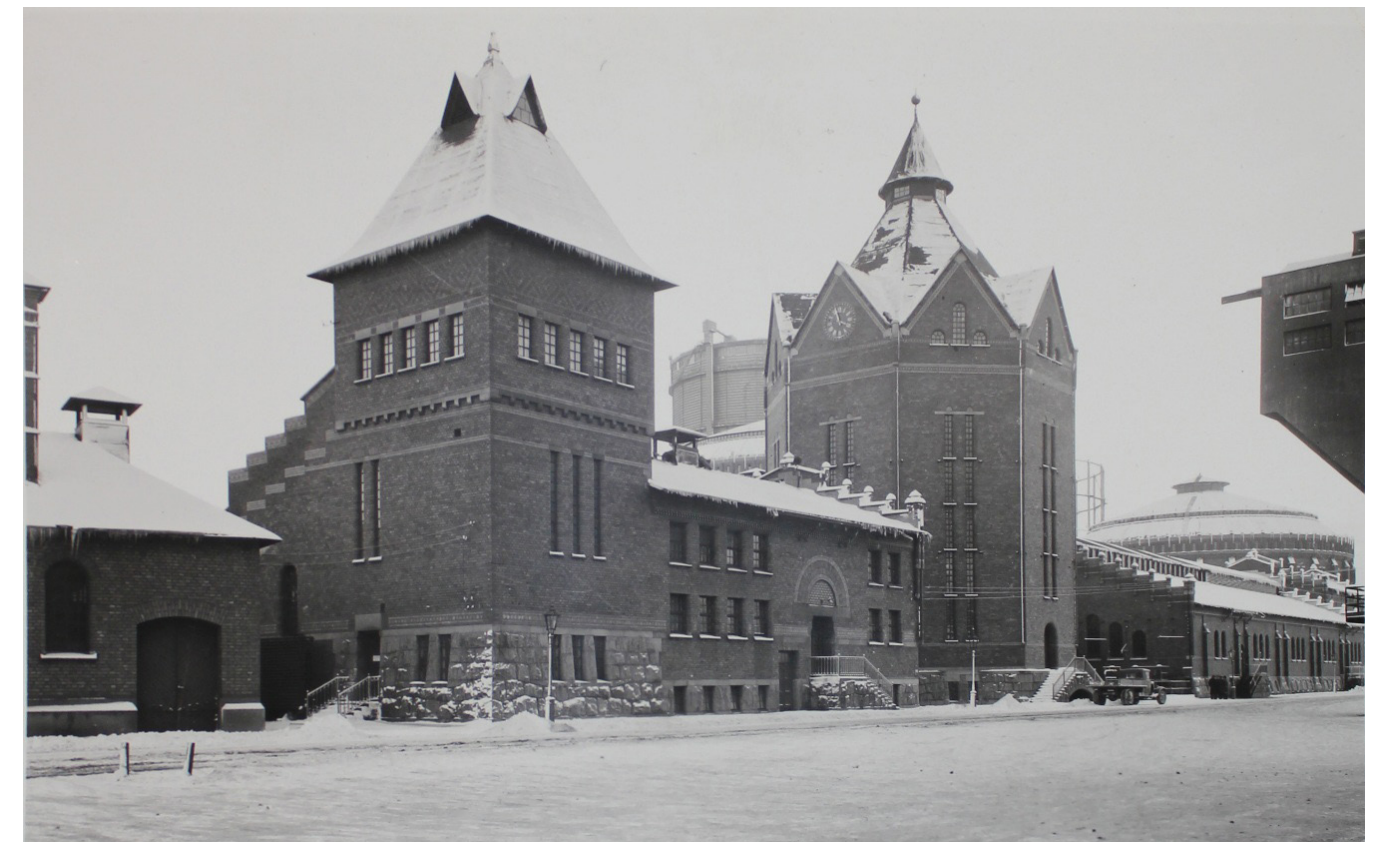
Värtagasverket, Scrubber- och maskinhus, 1937. Arkitekt var Ferdinand Boberg. Källa: Stockholmskällan.
