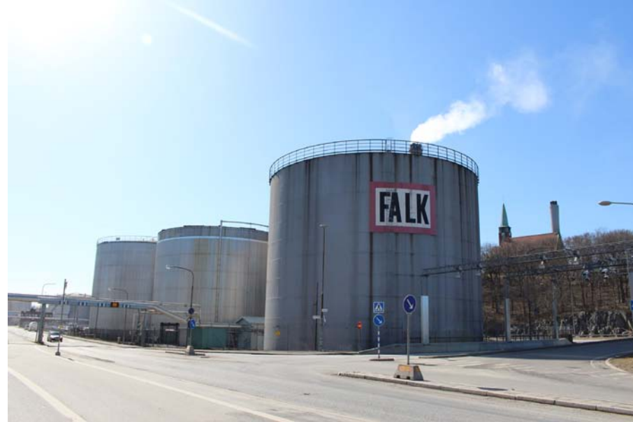
Cisterner i kvarteret Singapore längs med Norra Hamnvägen mot sydost. I bakgrunden syns Hjorthagens kyrka med en av Värtaverkets skorstenar i bakgrunden. Röken från den högsta skorstenen syns ovan cisternerna.
