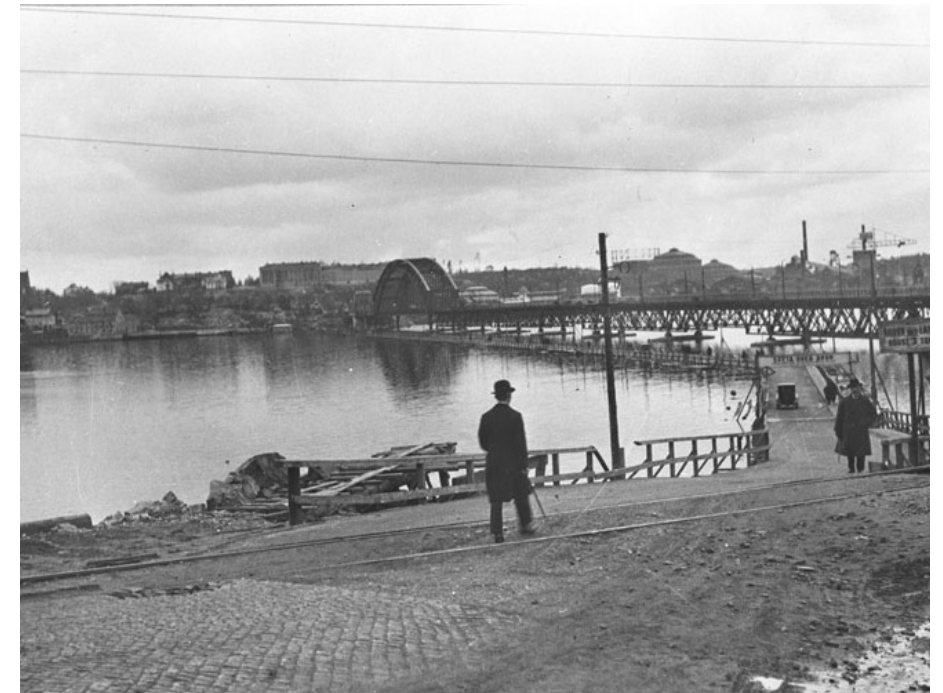
Vy österut från Lidingö mot nya Lidingöbron under byggnation i början av 1900-talet. I fonden Hjorthagen och Värtagasverket. Källa: Stockholmskällan.
