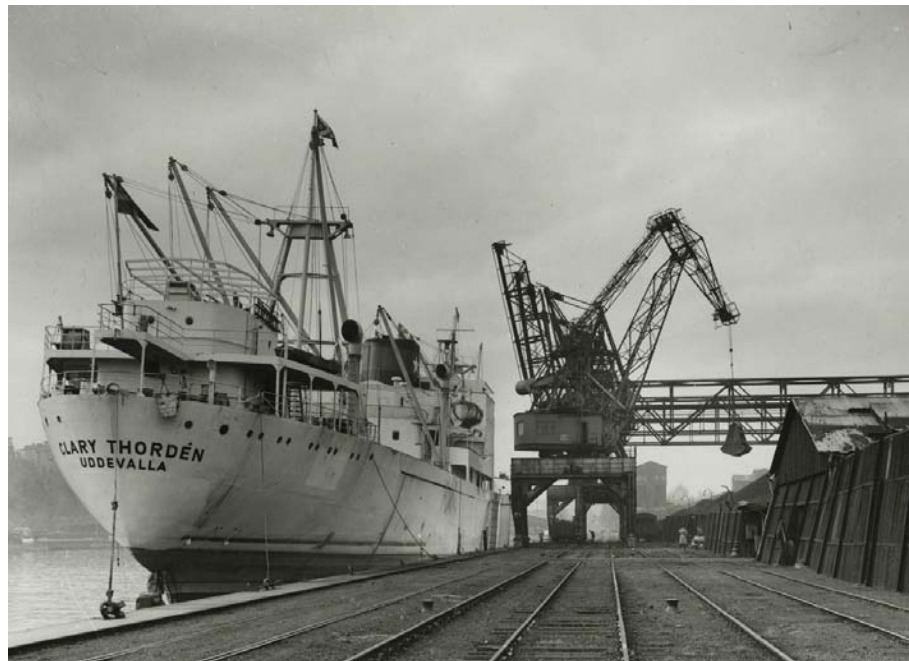
Kolsogning vid Värtahamnens norra bassängkant. M/s Clary Thordén byggdes 1954 vid Uddevallavarvet AB och sjösattes samma år. Bilden är från hösten 1955. Källa: Stockholmskällan.
