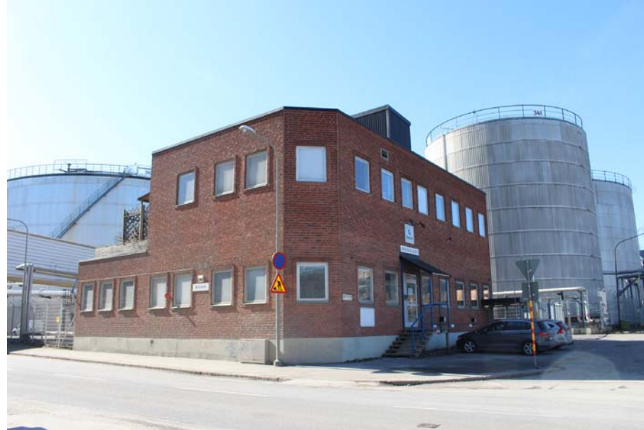
F.d. expeditions/kontorsbyggnad från 1958-59 vid Norra Hamnvägen. Ursprungligen var byggnaden uppförd i ett våningsplan men byggdes på 1968.
