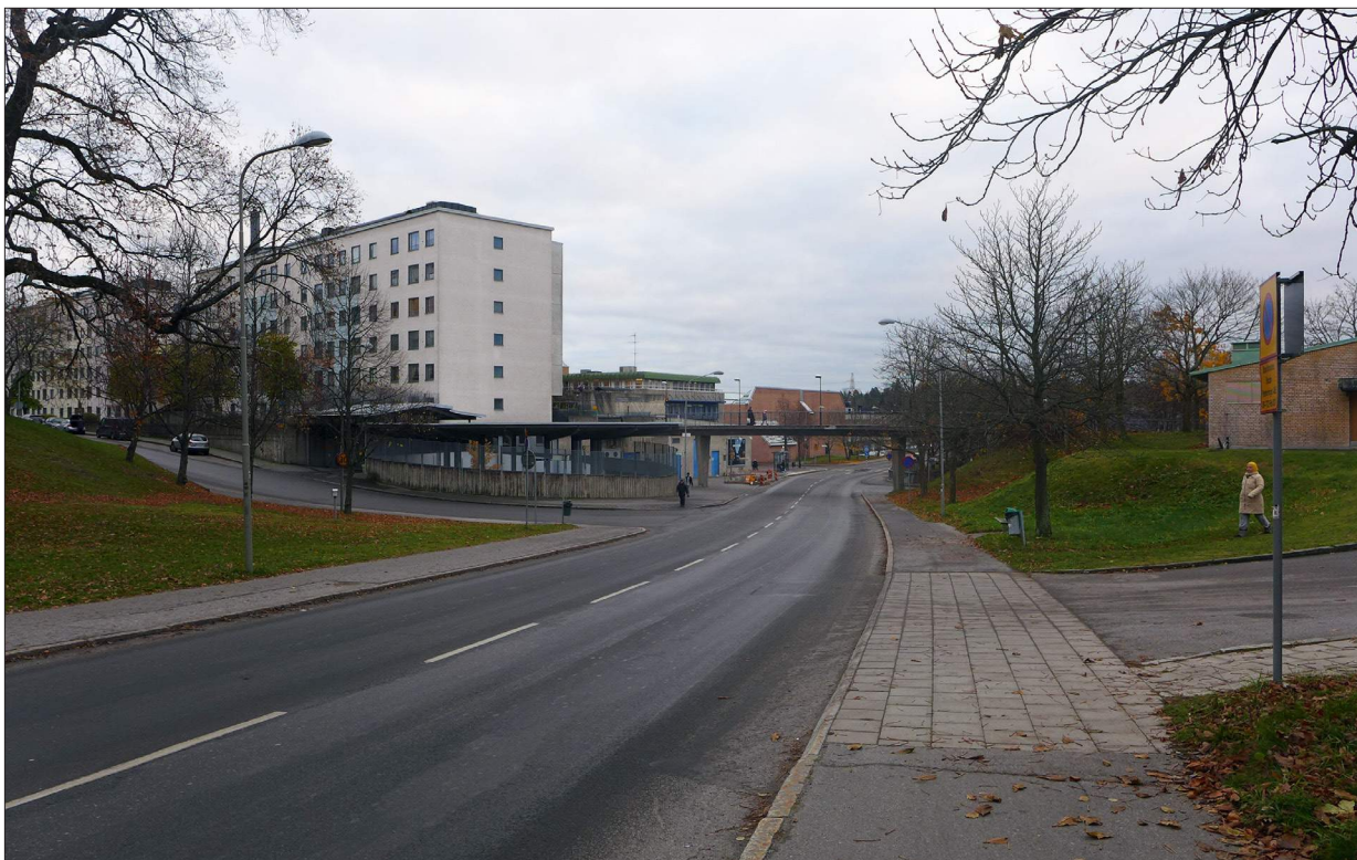
Ekholmsvägen i riktning mot centrum. De storskaliga skivhusen står i skarp kontrast mot den låga centrumbebyggelsen, den lågt liggande vägbanan och förskolan till höger i bild.
