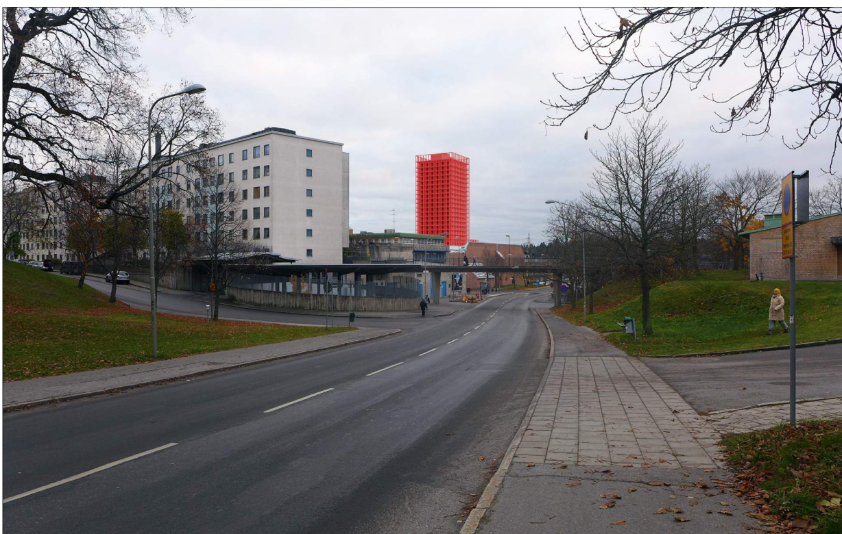
Den nya byggnaden samverkar med skivhusets fasad och bildar två separata men framträdande arkitektoniska motiv, av positiv betydelse för platsens upplevelsemässiga värden. Att skivhuset ligger på en högre marknivå än höghuset medför en viss inverkan på upplevelsen av landskapet. Sammantaget bedöms förslaget inte medföra någon negativ påverkan på platsens kulturhistoriska värden.
