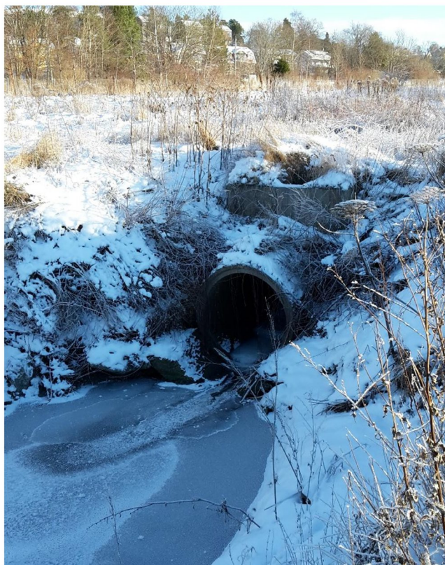
Foto 5. Anslutning av 1400mm till dike via brunn. Utlopp från brunn mot väster.
