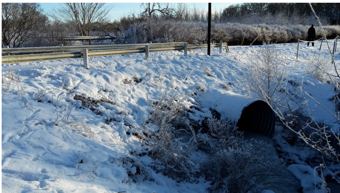
Foto 6. Passage under Riddersviks gårdsväg mot väster, via 1200 mm ledning.
