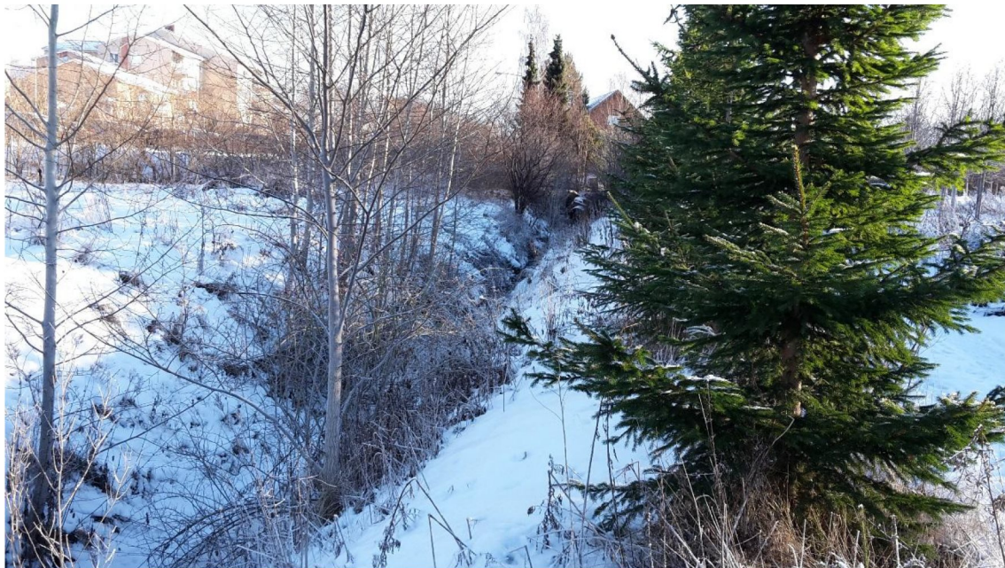
Foto 1. Diket, anslutning av 1000 mm ledning synlig vid dikets början
