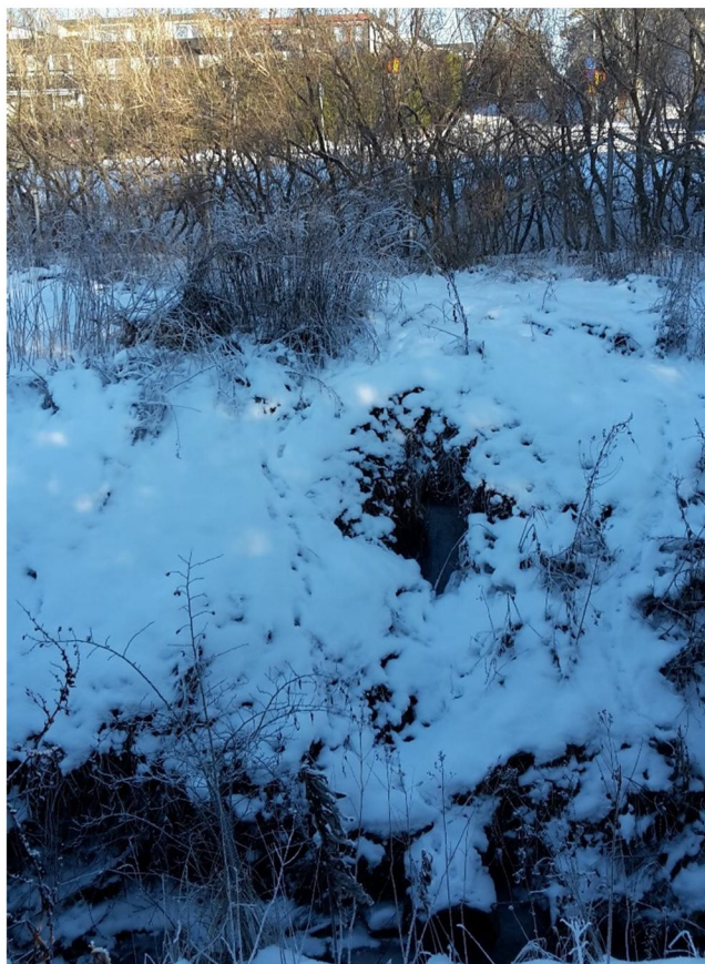
Foto 3. Anslutning av 400mm ledning från korsningen Löfstavägen / Glädjevägen.
