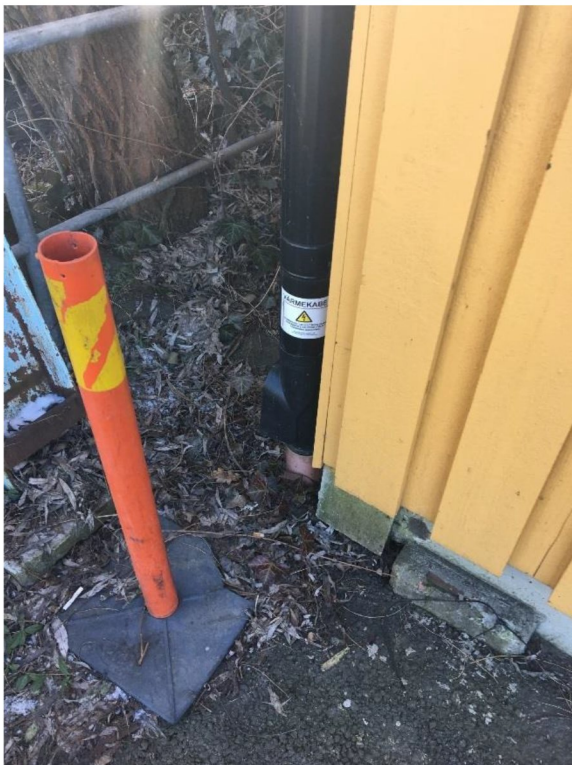
Stuprör som går ner i mark.
