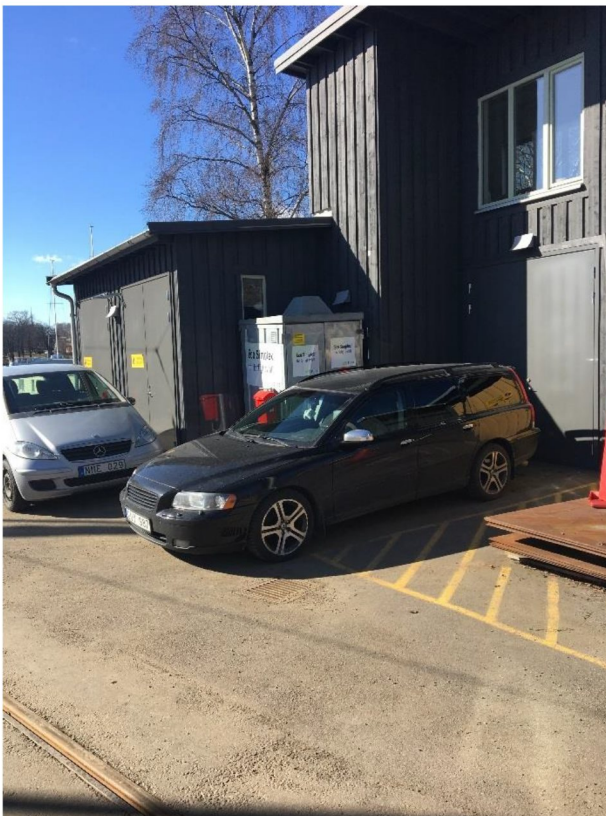
Dagvattenbrunn i lågpunkt på Falkenbergsgatan.
