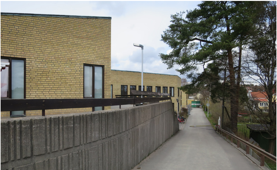
Nordöstra fasaderna av S:t Eriks katolska skola.
