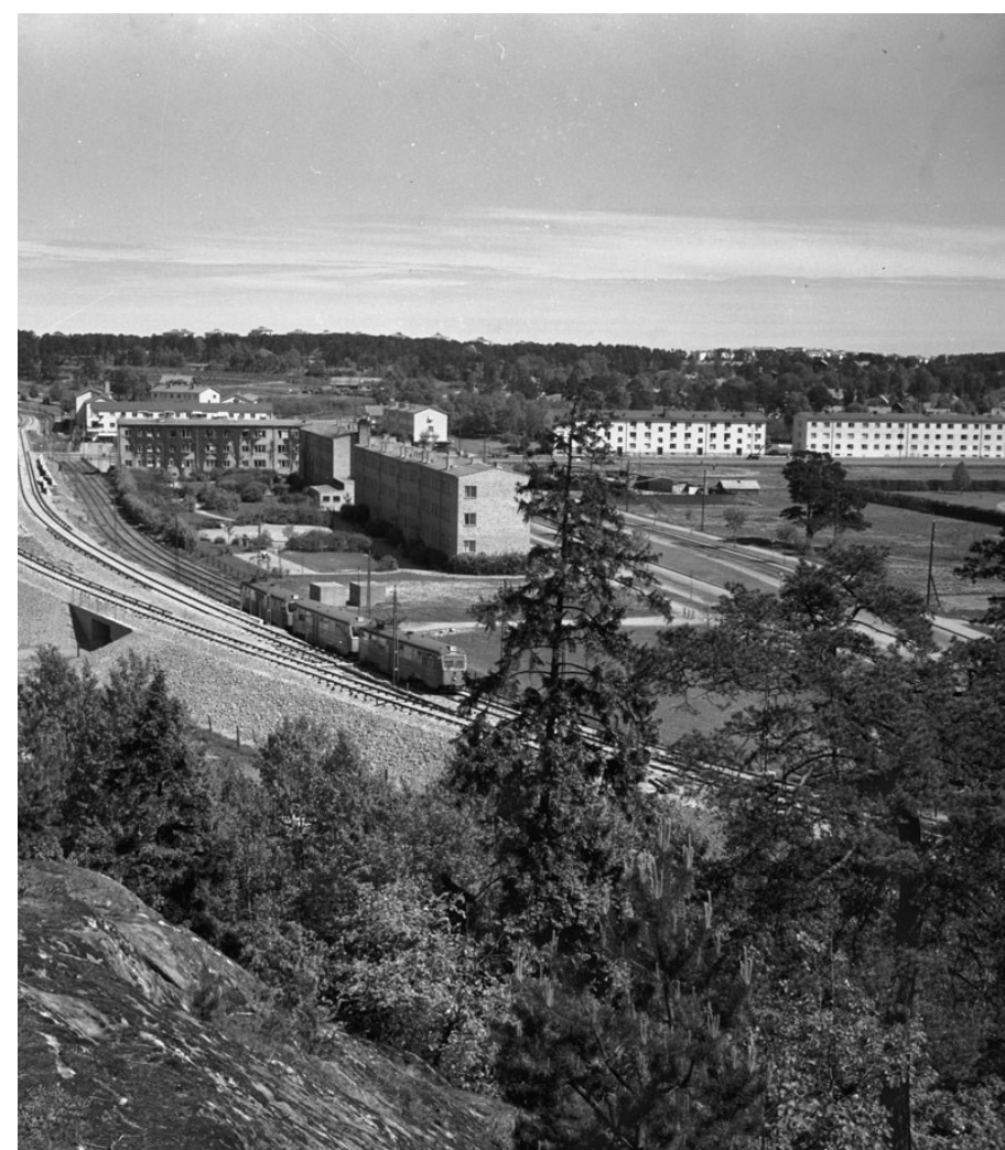
Det helt nya tunnelbanespåret, 1951. I bakgrunden syns de aktuella smalhusen. Källa: Stockholmskällan.
