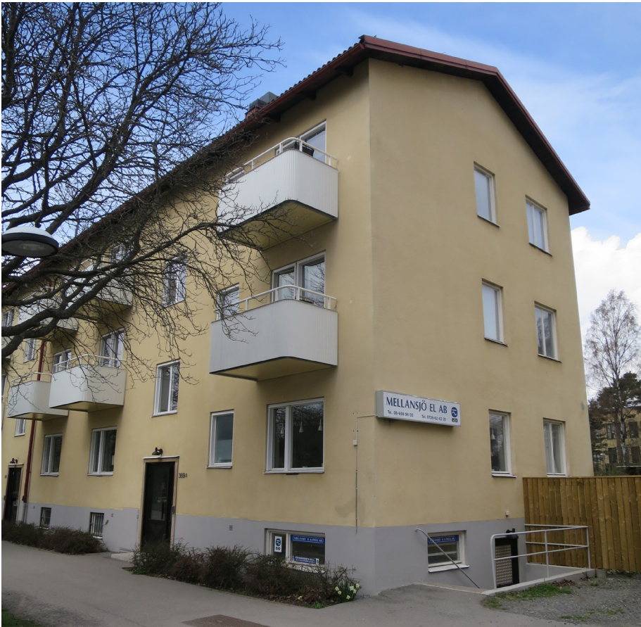
Smalhuset i Häradsdomaren 2 med nya anpassade balkonger.
