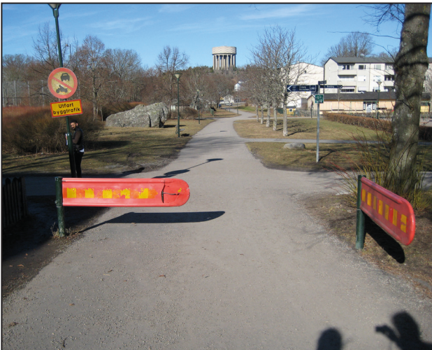
Påkörningsbar vägbom som står öppen.
