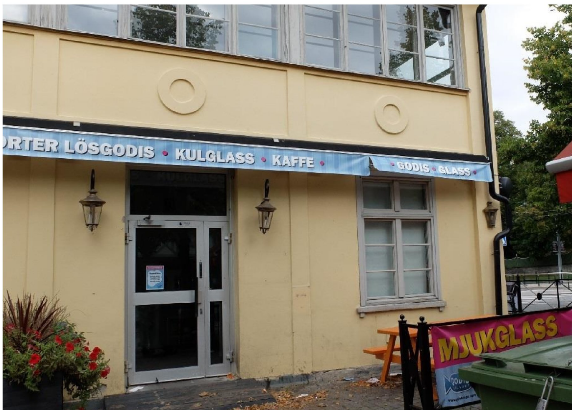
Entréparti i aluminium i hus B, dvs. 1920-talsbyggnaden. De övre fönstren är sannolikt ursprungliga.
