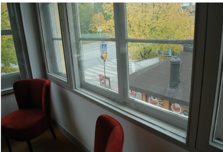
Fönster har tilläggsglas i bågar på insidan i hus B.
