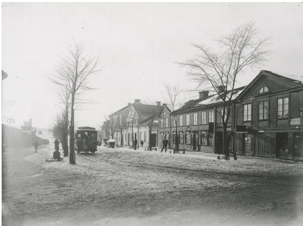
Bild på Allmänna gränd med restaurang Linden från 1895. Här syns de ursprungliga entréerna i bottenvåningen som togs bort sannolikt vid renoveringen på 1910-talet. Till höger ses vinkelbyggnaden som upptog hörnet Djurgårdsvägen-Allmänna gränd innan den revs inför 1897 års utställning. Bilden är hämtad från Stockholms digitala stadsmuseum.
