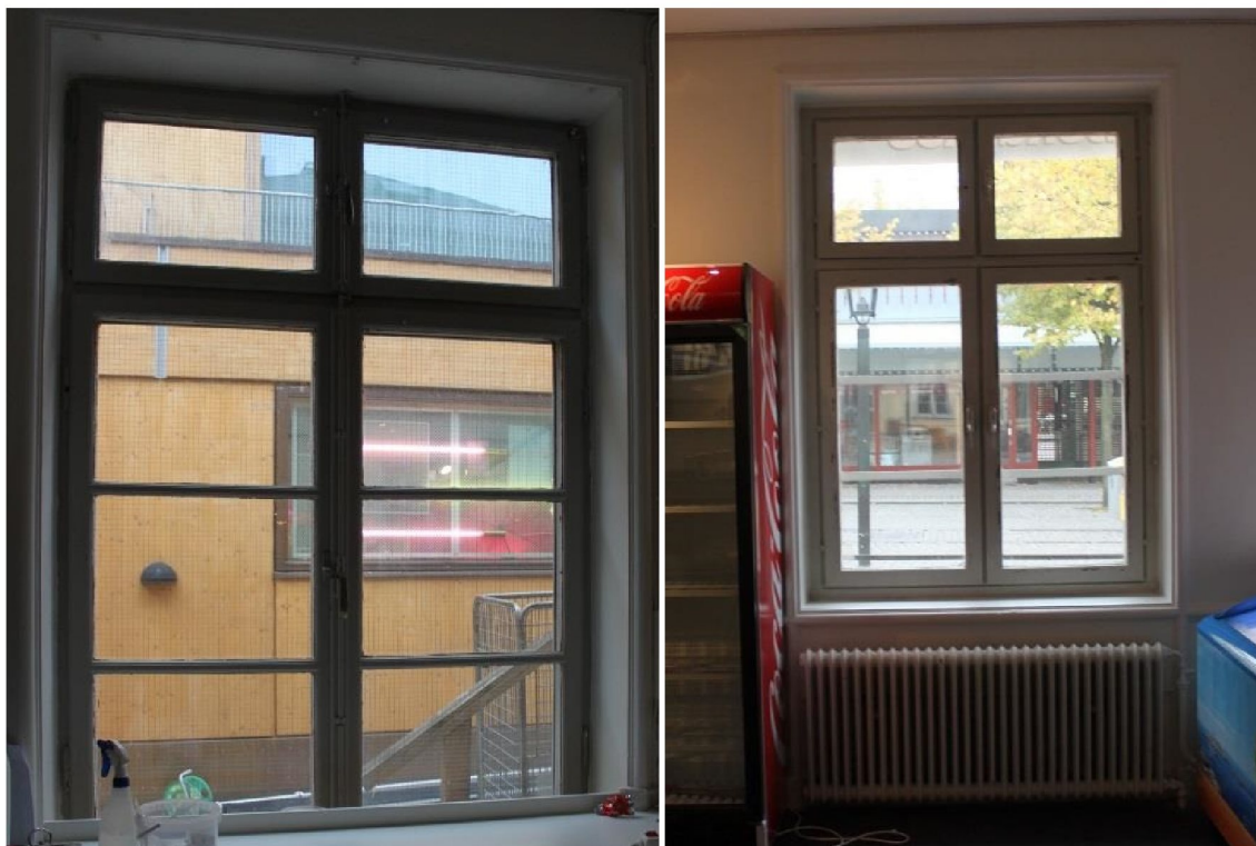
Fönstret till vänster i 1920-talsbyggnaden, hus B, som kan vara original medan det till höger är senare.
