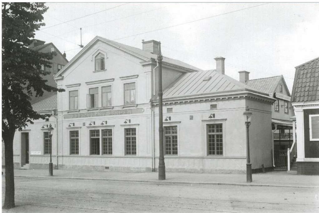
Restaurang Linden, hus A, på 1920-talet. Här har två av de ursprungliga dörrarna byggts igen och bottenvåningen fått småspröjsade fönsterbågar som är mer typiskt för början av 1900-talet än 1880-talet. Dessa tillkom sannolikt vid ombyggnaden på 1910-talet. Träbyggnaden intill revs senare för att uppföra sommarpaviljongen. Bakom ligger konditoriet Lindgården - här kan man även skymta pergolan som kan ha uppförts vid ombyggnaden 1923. Bilden är hämtad från Stockholms digitala stadsmuseum.
