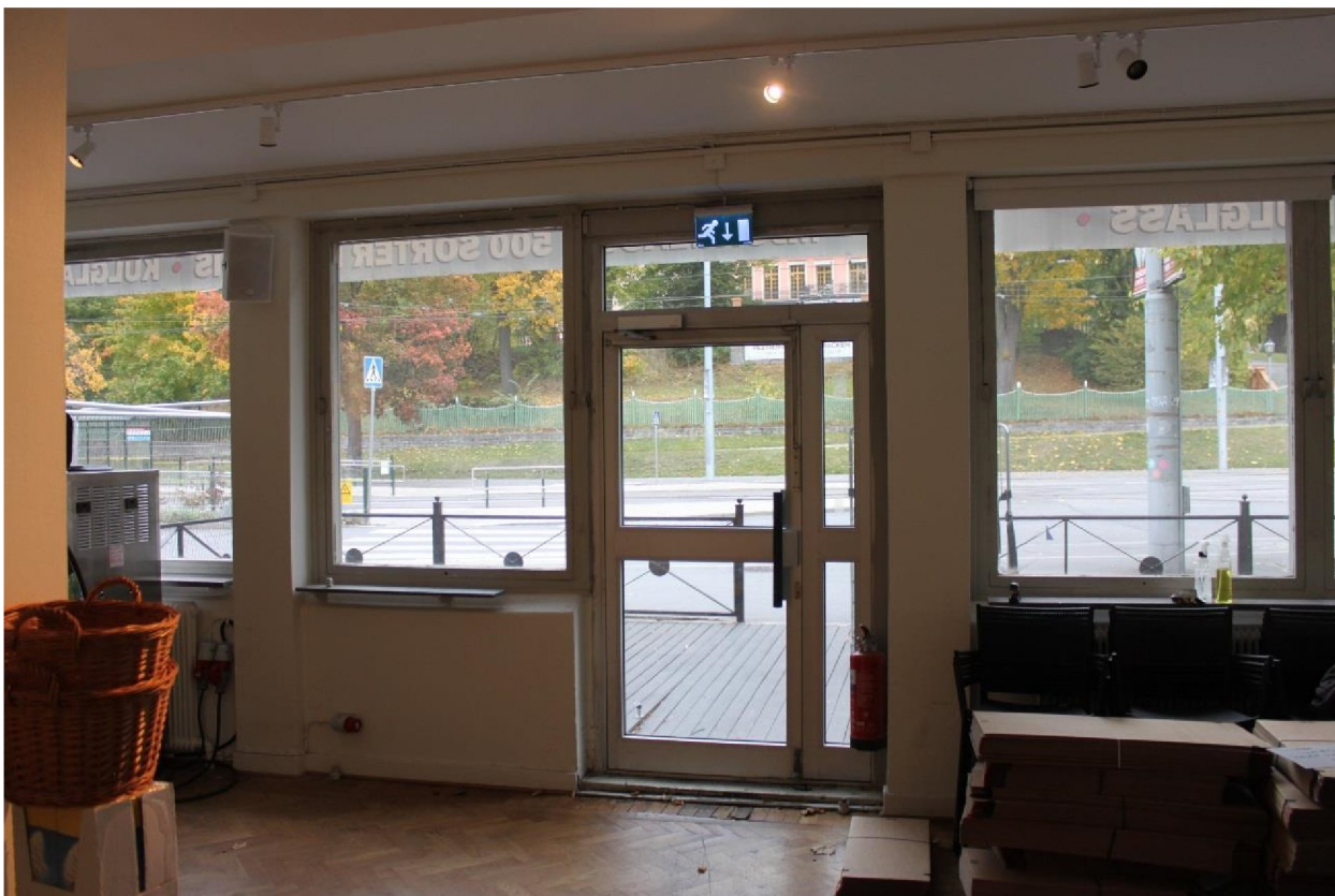
Konsthallen 15 inifrån mot Djurgårdsvägen, hus B, med senare insatta fönster och dörrparti i aluminium. Denna del var för början en uteveranda.
