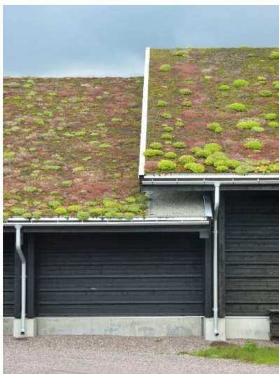
Figur 10. Exempel på sedumtak. Foto: WRS
