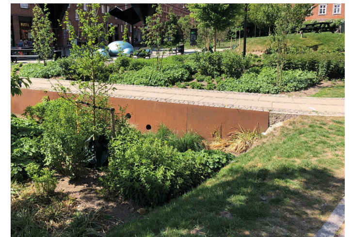
Planteringsyta utformad för omhändertagande av varierande mängder dagvatten, med torktåliga växter.
