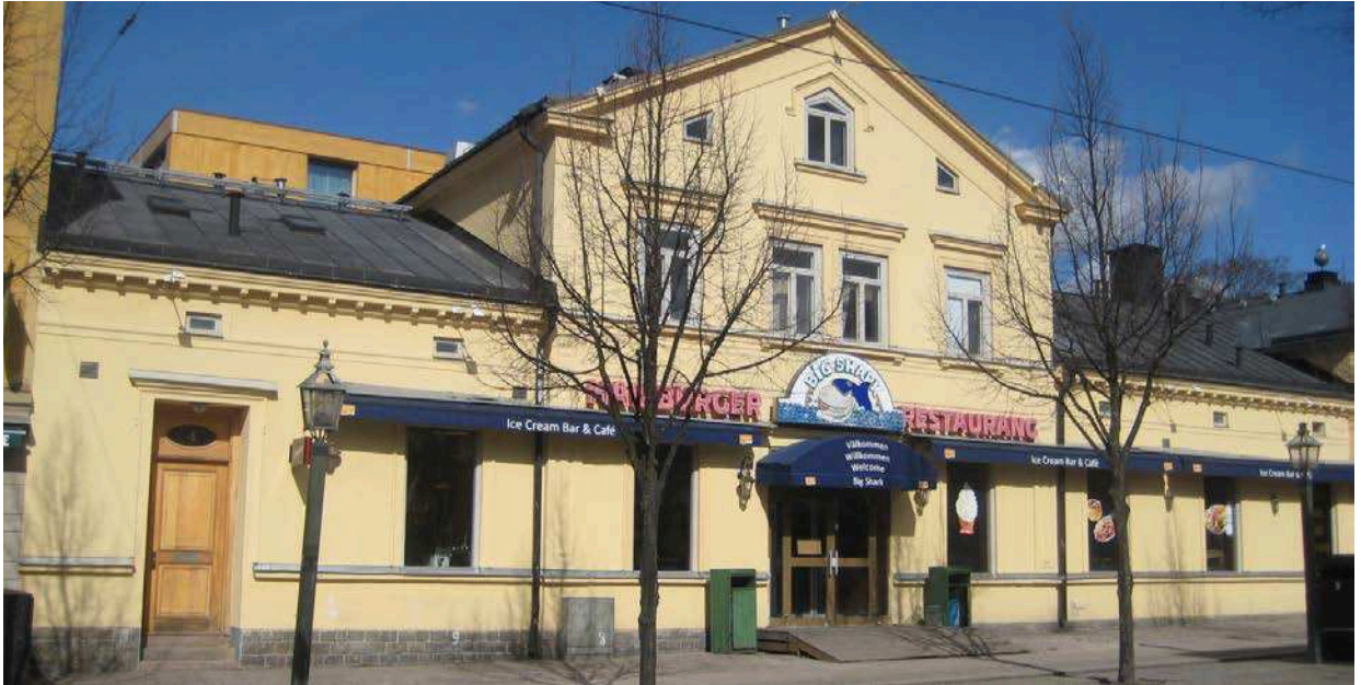
Huvudbyggnadens fasad mot gatan. Till vänster kontorsentrén med port av eksnickeri och i mitten glasade aluminiumpartier vid restaurangentrén. Fönstersnickeri av instickstyp i de övre våningarna och hela ospröjsade rutor i gatuplanet. Sammanhängande fasadmarkiser längs nästan hela fasadsträckan.
