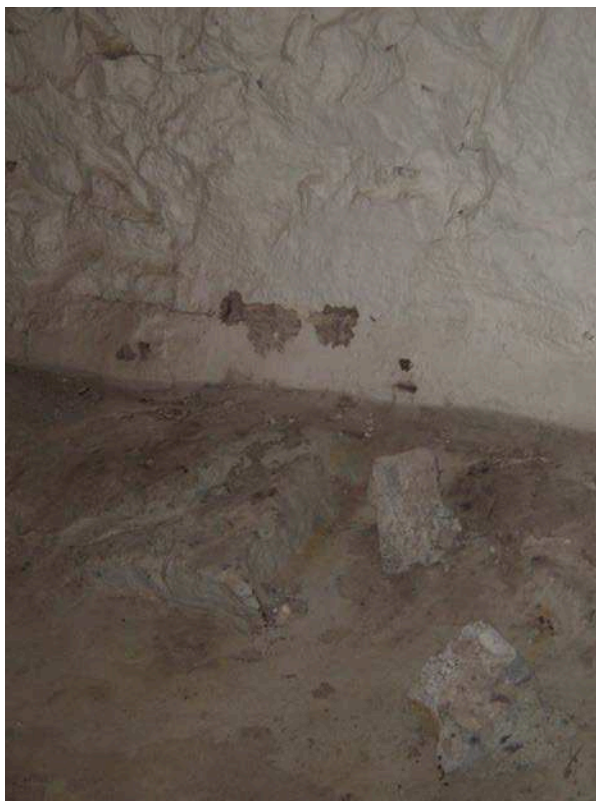
”Berg i dagen” förekommer i huvudbyggnadens källarutrymmen.
