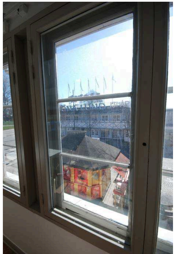
Fotografier från tillbyggnadens övervåning.
