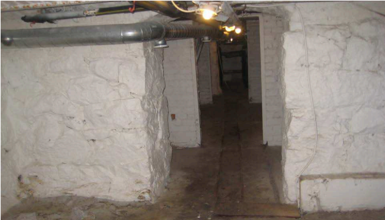
Exempel på murverk i källarutrymmena. Både natursten och tegel före-kommer. Alla vägg- och takytor är övermålade med en vit täckfärg.
