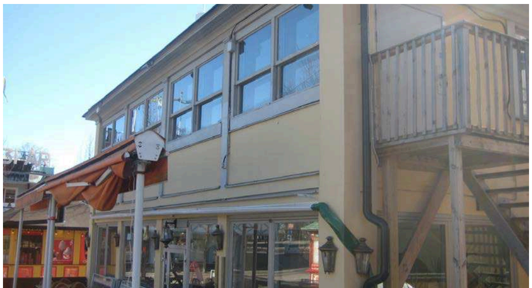
Tillbyggnadens fasad mot öster. Sentida skivinklädnad i underkant av övervåningens fönster. Till höger utvärdig utrymningstrappa av provisorisk karaktär.
