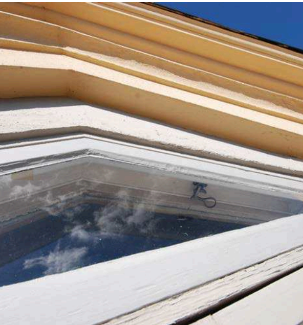
Överst fasaddetalj huvudbygganden. Därunder tillbyggnadens fasad mot gränden i norr. Underst frontespisens fönster med kraftig, putsad instickskarm.
