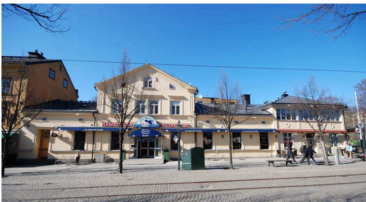
Ovan tillbyggnadens fönster mot Allmänna gränd. Nedan byggnadens fasad mot Allmänna gränd. Till vänster huvudbyggnaden från 1880-talet, till höger 1920-talets tillbyggnad. Foto mot norr.
