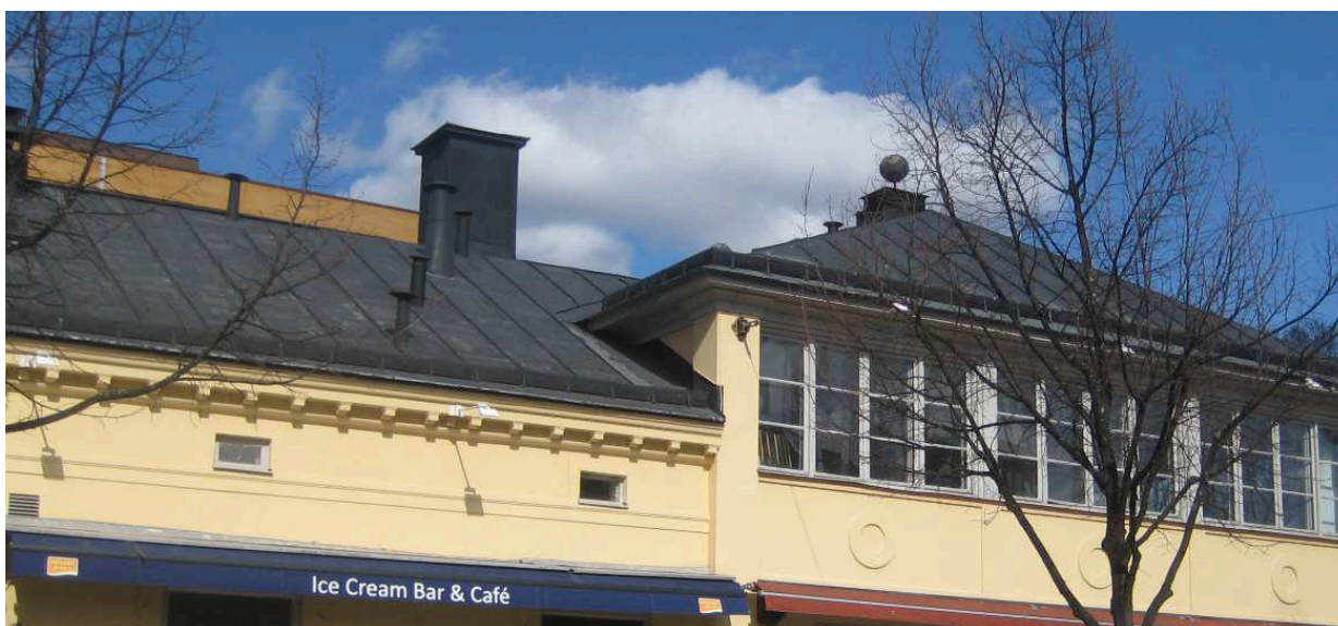
Fasad mot söder. Takyterna på hela byggnaden är belagda med svartmålad slät stålplåt i skivformat. Takavvattning via ståndrännor och utvändiga stuprör med utkastare vid mark.
