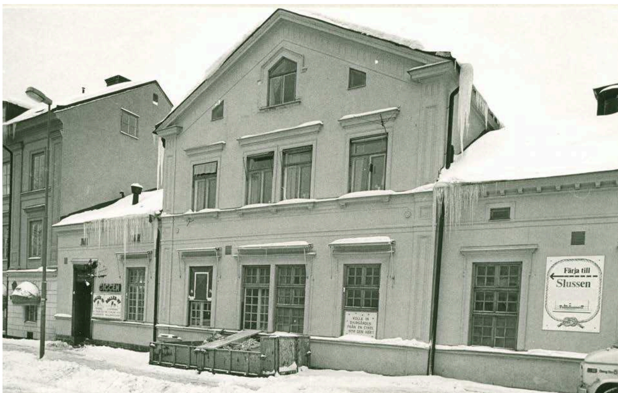
Fotografiet visar byggnadens fasad mot Allmänna gränd 1982. Byggnaden har äldre spröjsade fönsterbågar utan instickskarm. Några av fönstren är emellertid ändrade sedan fotografiet ovan togs. Stockholms stadsmuseum.
