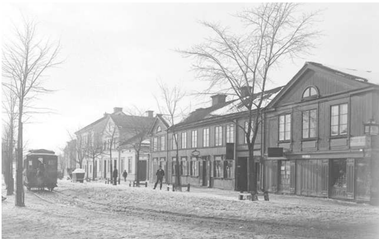
På detta foto från 1890-talet ses byggnaden med två entréer i frontespisen, likt på nybyggnadsritningen. En sidoentré ses också i den södra flygeln. Sannolikt byggdes restaurangentréerna mot gatan om till fönster redan på 1910-talet. Till höger ses den stora vinkelbyggnaden som upptog hörnet Djurgårdsvägen-Allmänna gränd. Den revs inför världsutställningen 1897. Stockholms stadsmuseum
