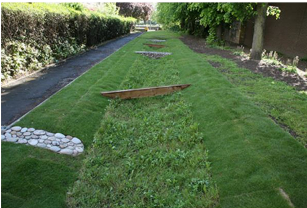
Figur 11. Exempel på utformning av svackdike (Källa: Rent dagvatten).
