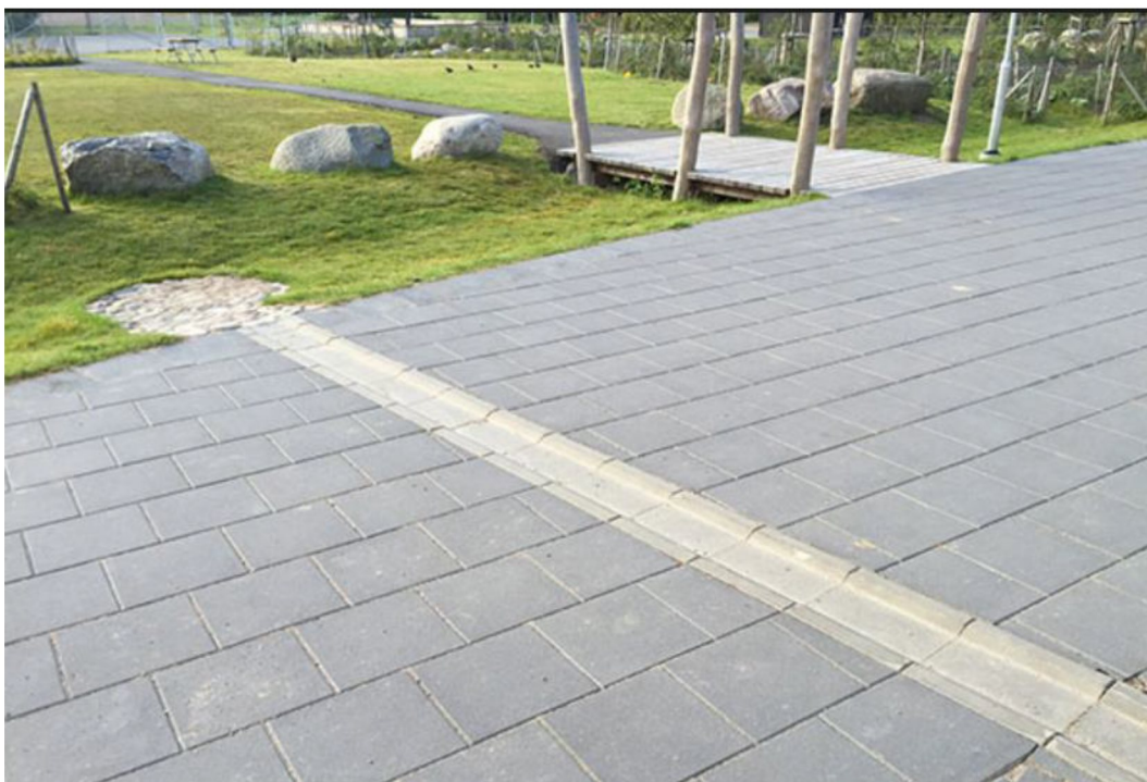
Figur 10. Rännalsplattor för avledning av dagvatten från hårdgjorda ytor till grönytor.
