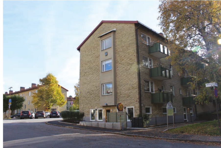
Kv. Stjärnvalvet och Kryssvalvet i stadsdelens nordvästra del utgörs av nio likartade lamellhus med fasader i gult tegel. Husens ursprungliga karaktär har förändrats genom inplätning av fönster samt ändring av balkonger.
