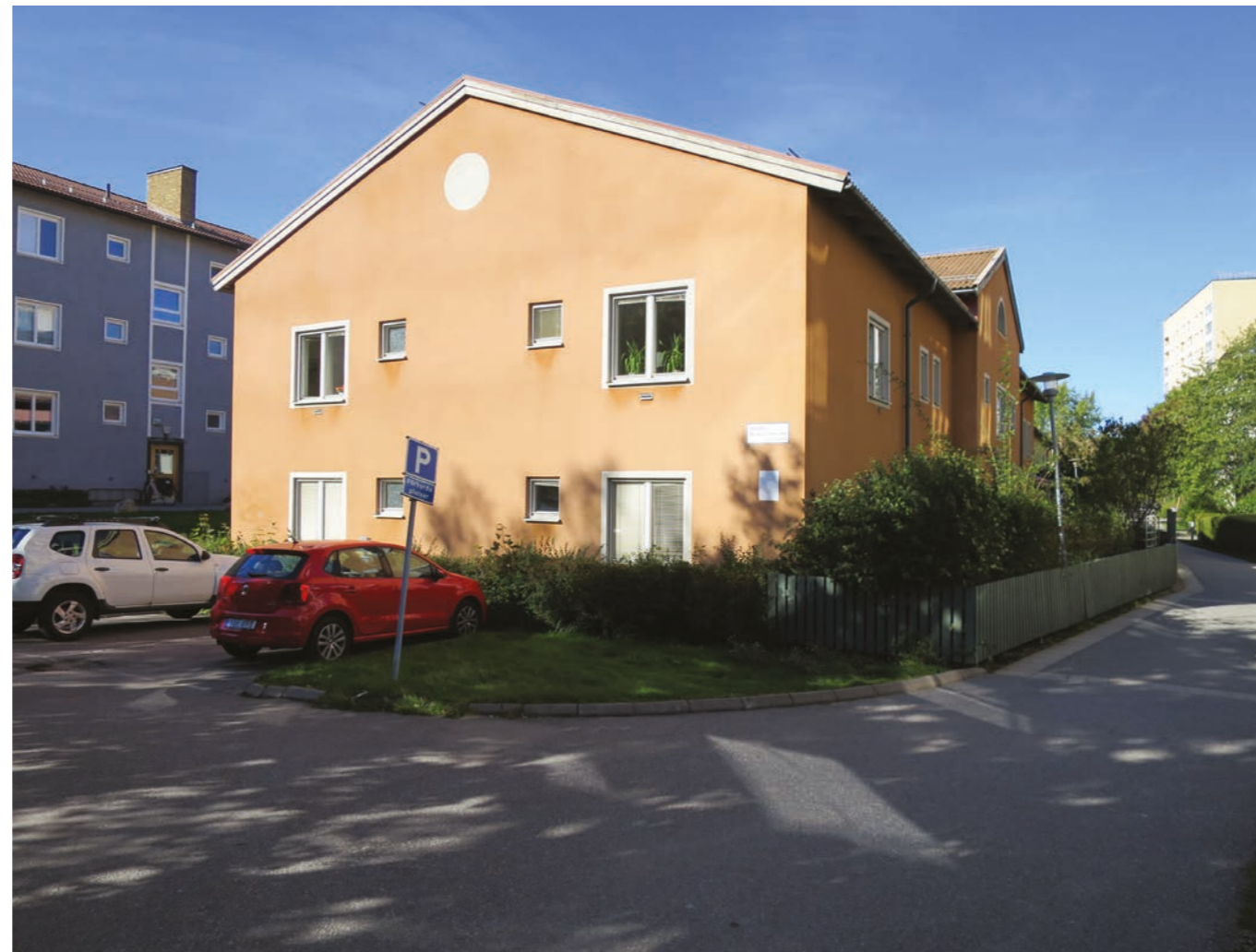
Färgfotot 3, omedelbart söder om Färgfotot 2, är gruppbestäder för senildementa, ritade av Axel Forsén, Brunberg & Forshed 1992. Byggnaden ligger mer indragen i kvarteret och skiljer sig även från övriga med historiserande uttryck – ockrafärgad fasad och vissa klassiska element såsom en centrerad risalit med spröjsat lunettfönster i mittgavelpartiet
