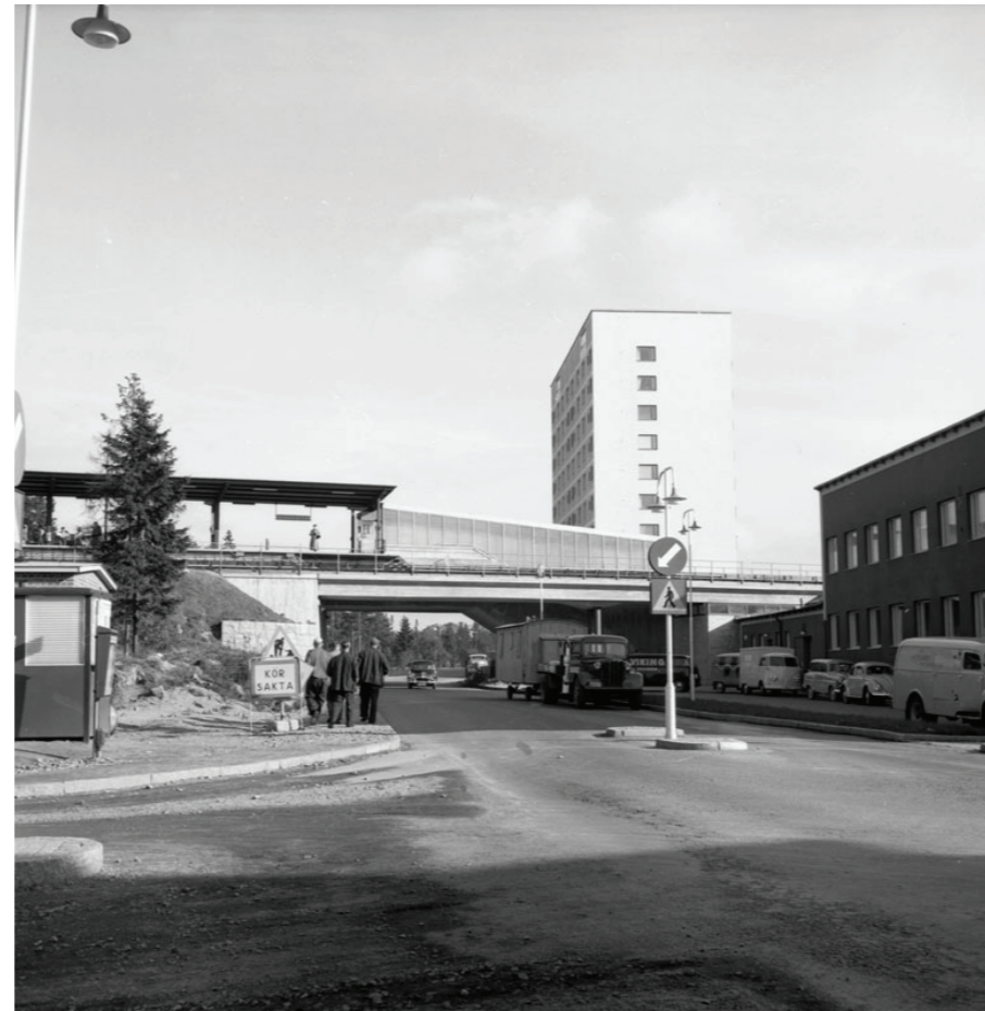
Foto från 1954 som visar tunnelbanan från väster med skivhuset i fonden och baksidan av ena butikslängan till höger. Till vänster i bild skymtar grönytan med transformatorstationen som omfattas av planförslaget. Stockholmskällan.
