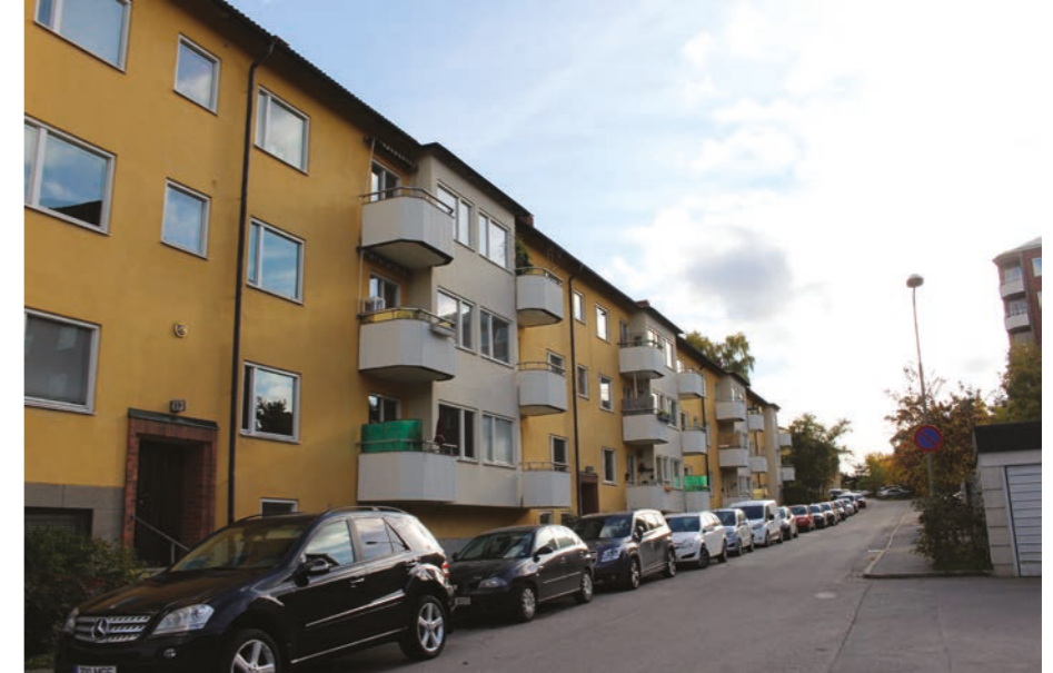
Putsat lamellhus i tre våningar längs med Fågelstavägen. Punkthusen skymtar på andra sidan vägen.
