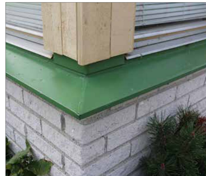
Detalj fasader av kalksandsten och fönsterbleck av grönmålad plåt.
