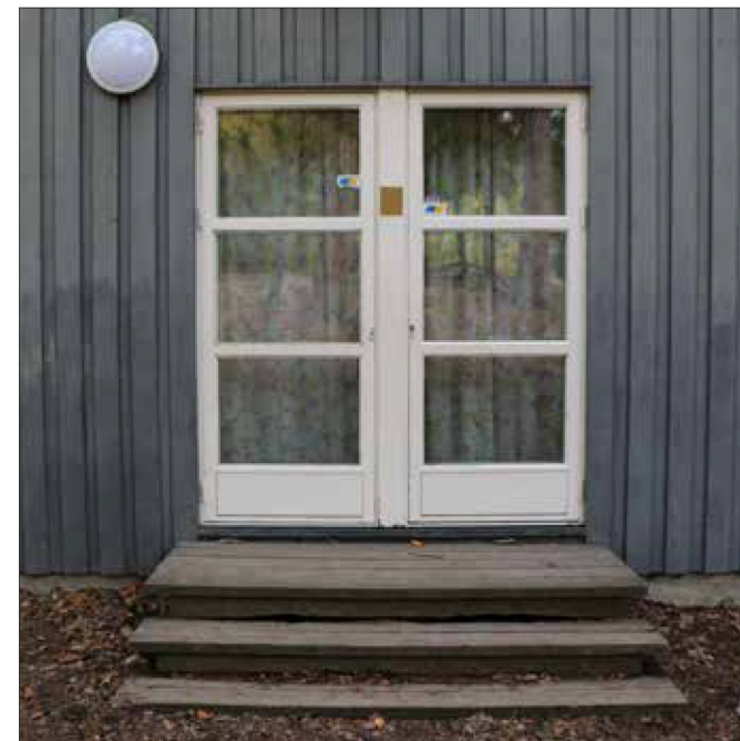
Franska fönster, dörrar med träpartier.
