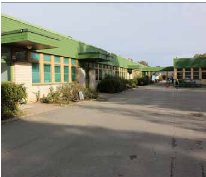
Hus B med skärmtak över skolans entréer.
