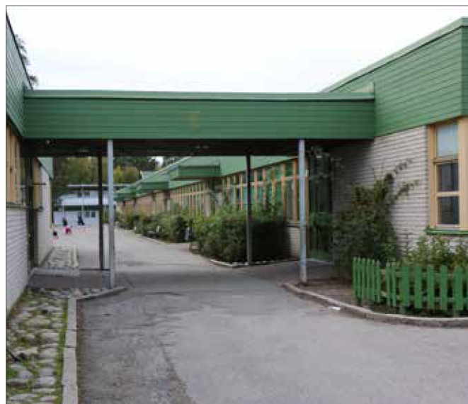
Förbindelsegång mellan Hus A och B.
