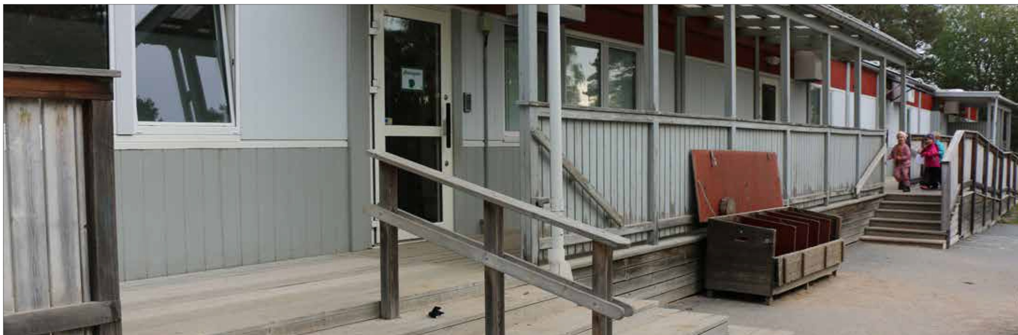
Tillfällig förskolepaviljong uppförd 2007.
