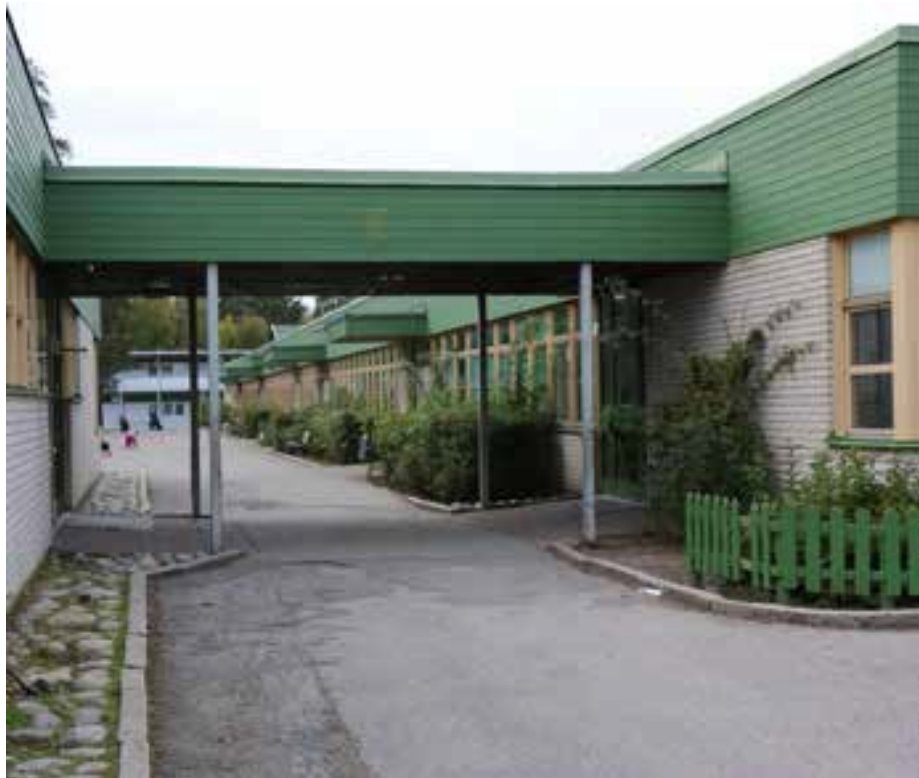
Förbindelsegång mellan Hus A och B. Byggnaderna bedöms ha särskilt höga kulturhistoriska värden. Foto: Tengbom.
