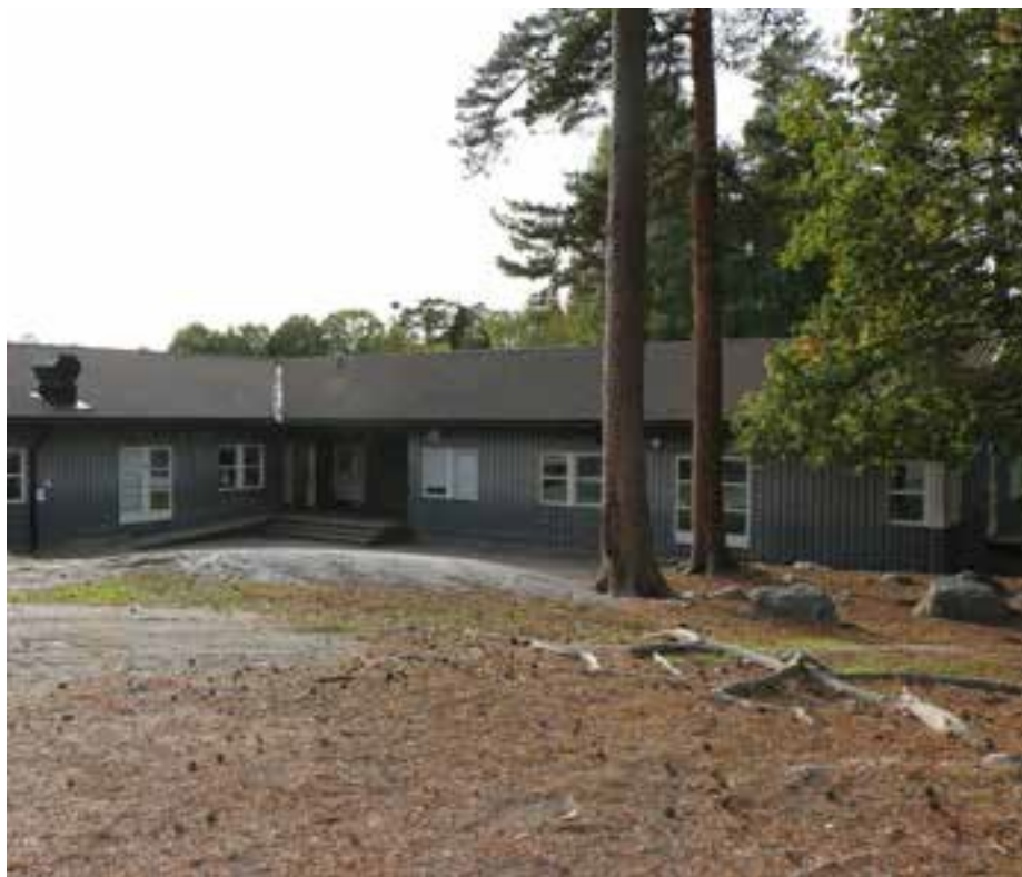
Fritidshem från 1982 som bedöms ha positiv inverkan på stadsbilden och visst kulturhistoriskt värde. Foto: Tengbom.
