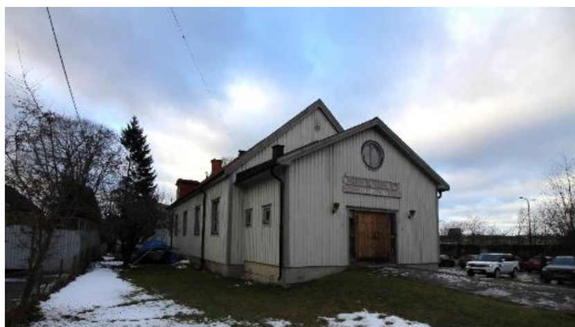
Örbykyrkan Filadelfia med huvudentré tillbyggd 1983 (Tyréns, 2018).
