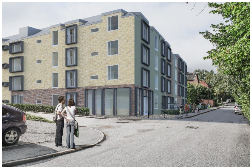
Korsningen Malmköpingsvägen/Västermovägen med lokal i bottenvåningen, vy mot sydväst (Reierstam Arkitektur 2018).
