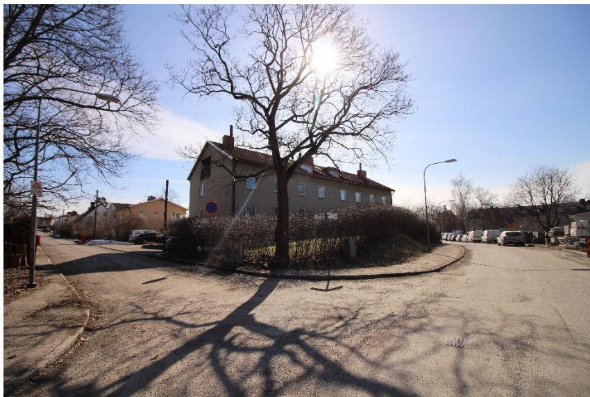
Flerbostadshus i två våningar utmed Malmköpingsvägen. Byggnaden är vinklad vilket skapar ett större indrag från gatan.
