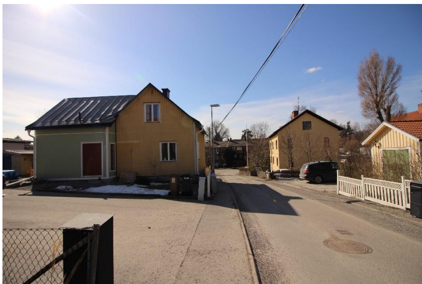
Äldre villa på Frustunavägen. Troligtvis från 1940-tal. Gatan är smal och bebyggelsen låg i en till två våningar. Foto 2018-03-30
