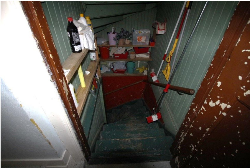
Trappan leder ner till källarvåningen i Örbykyrkan. Trappan, handledaren och troligtvis färgsättningen är ursprungliga. Foto januari 2018.
