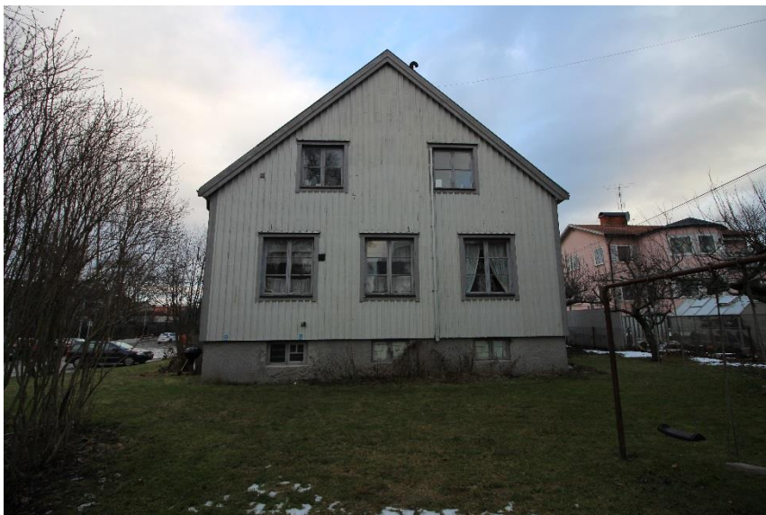
Örbykyrkan Filadelfia med panelklädd gavelsida på byggnadens baksida. Fönstren på gavelsidan är ursprungliga men något insjunkna i fasaden till följd av tilläggsisoleringen. Foto januari 2018.
