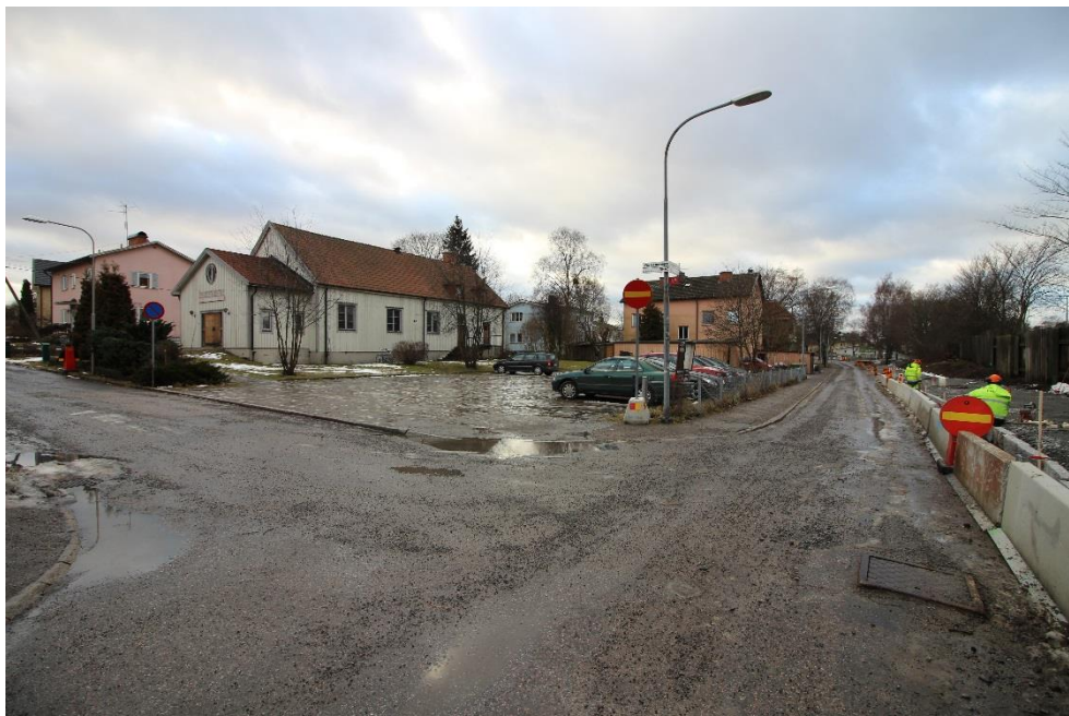
Kv. Självstarten i korsningen Malmköpingsvägen och Västermovägen. Närmast två sammanslagna tomter med Örbykyrkan Filadelfia och parkering. Anläggande av en cykelväg pågår längs med Malmköpingsvägen t.h. i bild. Foto januari 2018.
