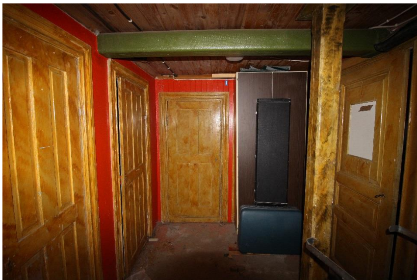
Källarvåningen i Örbykyrkan med ådringsmålade dörrar och betonggolv. Foto januari 2018.
