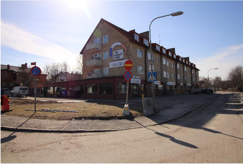
Flerbostadshus i tre våningar med inredd vind och butiker i bottenplan. Huset är uppfört utmed Malmköpingsvägen, indraget från gatan. Foto 2018-03-30
