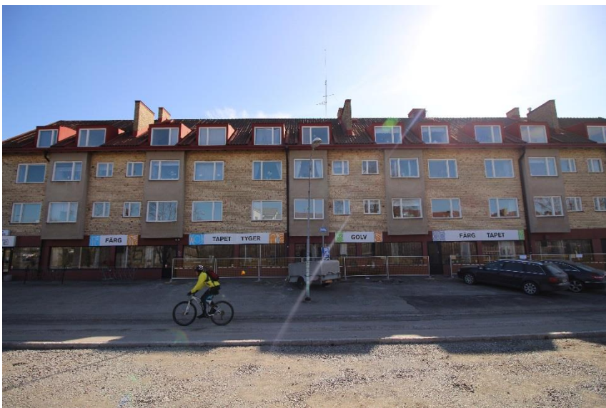
Flerbostadshus i tre våningar med inredd vind och butiker i bottenplan. Huset ligger i kv. Vevstaken. Byggnaden är den högsta utmed Malmköpingsvägen och ligger relativt djupt indraget från gatan.
