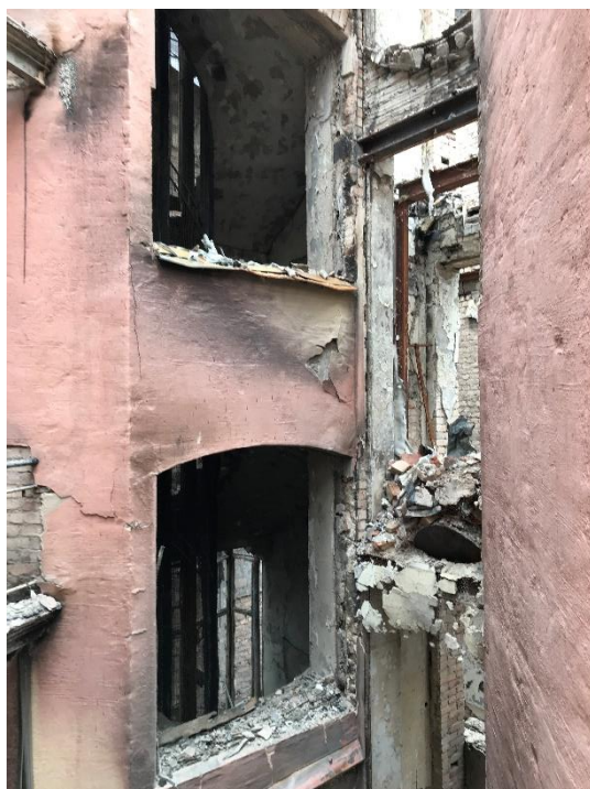
Fönsteröppningar mot trapphuset mot Biblioteksgatan
