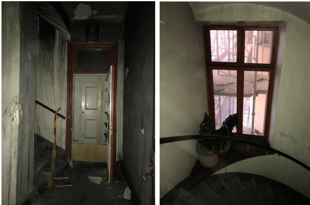
Trapphuset i gårdsflygeln
