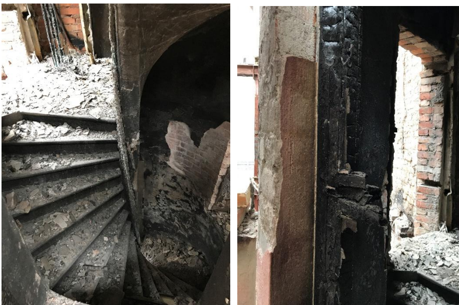
Trapphus mot gården i kontorsdelen.
