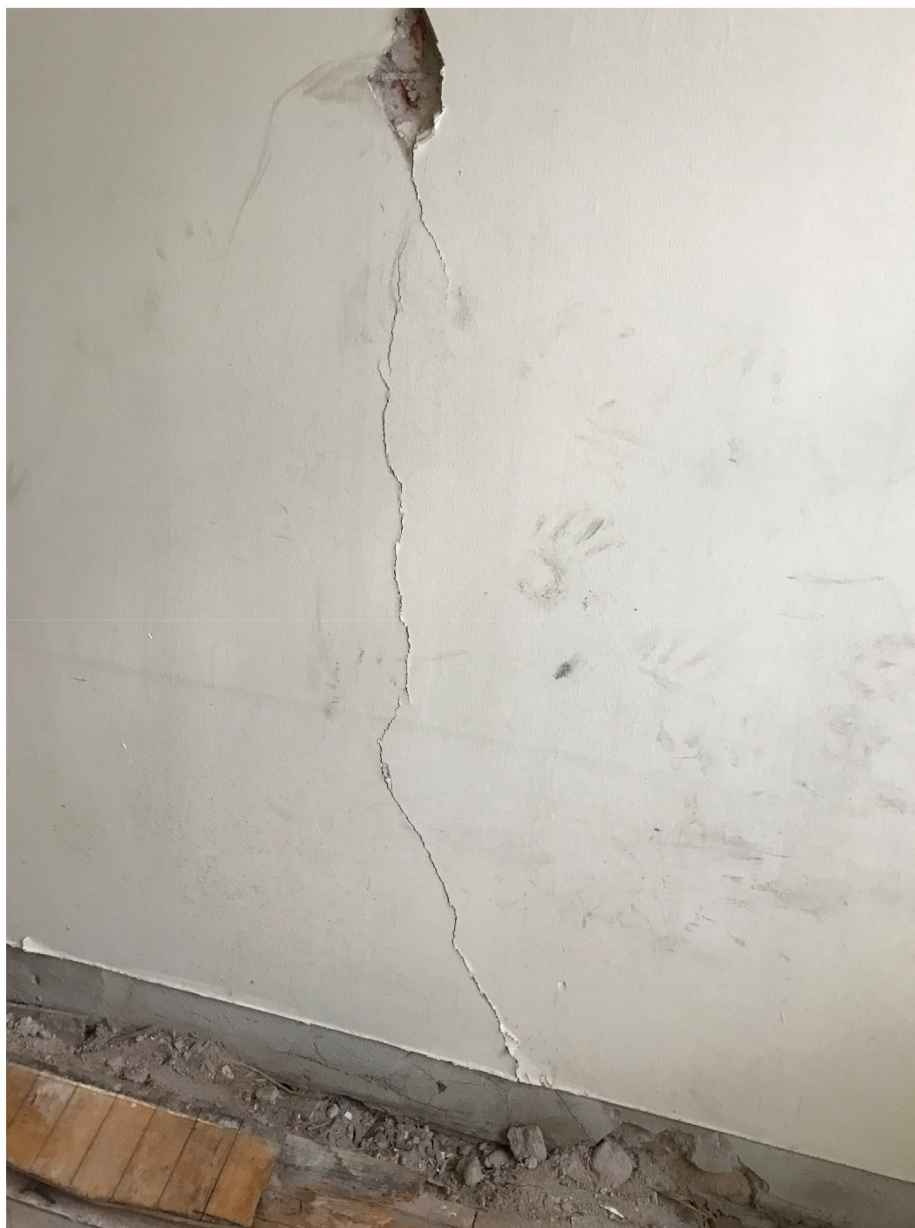
Figur 11: Sprickor i tegelvägg mellan kontorsdel och bostadsdel. Bild tagen 2018-06-14.
