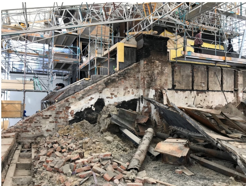
Figur 3 Vindsbjälklag över bostadsdelen. Bild tagen 218-06-14.
