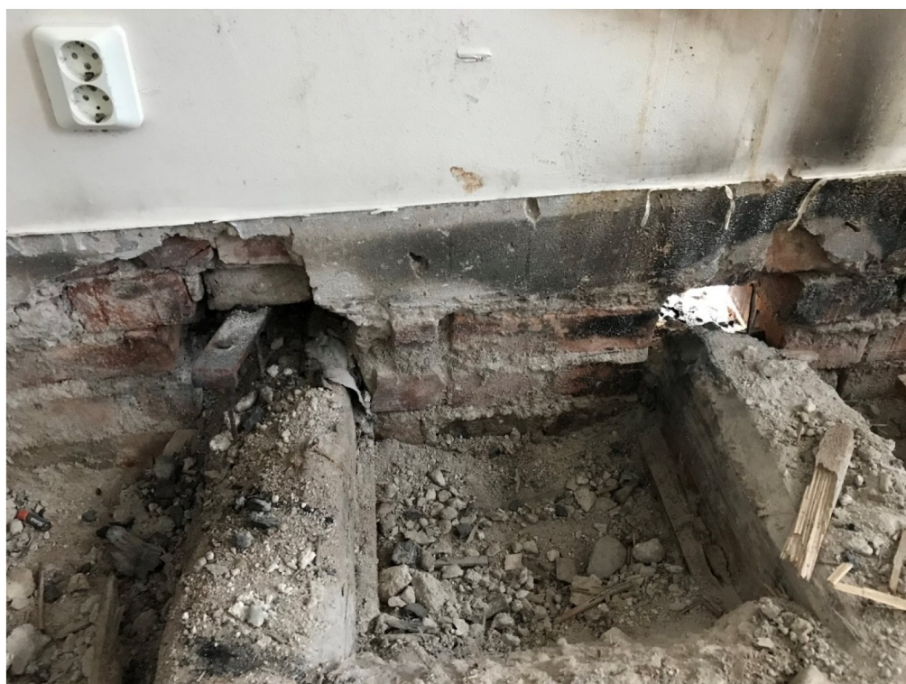
Figur 4 Träbjälkar i bostadsdelen på plan 2. Bild tagen 2018-06-14.
