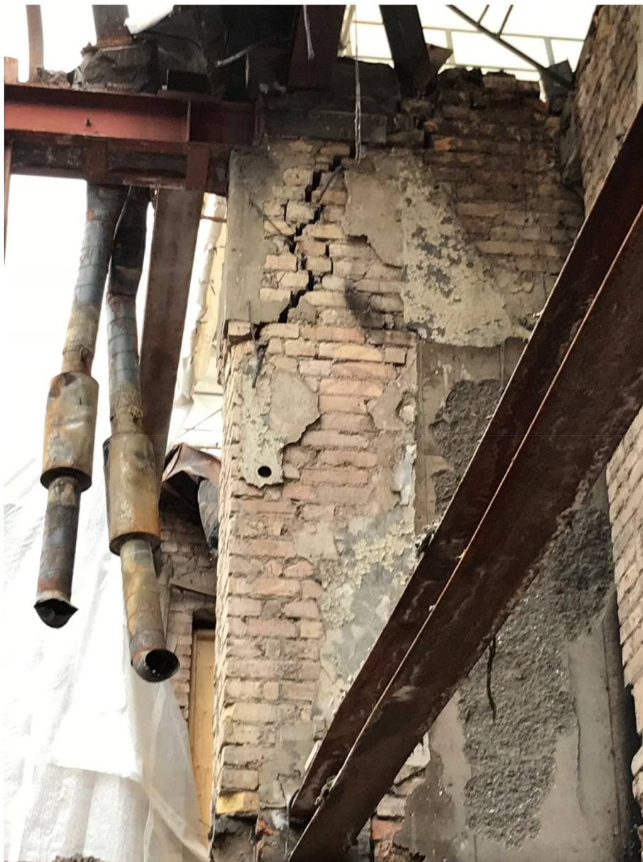
Figur 10: Spruckna hjärtväggar av tegel i kontorsdelen. Bild tagen 2018-06-14.
