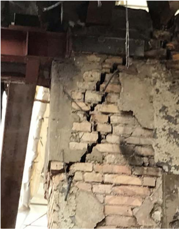
Spruckna hjärtväggar av tegel i kontorsdelen. (Looström|Gehlin)
