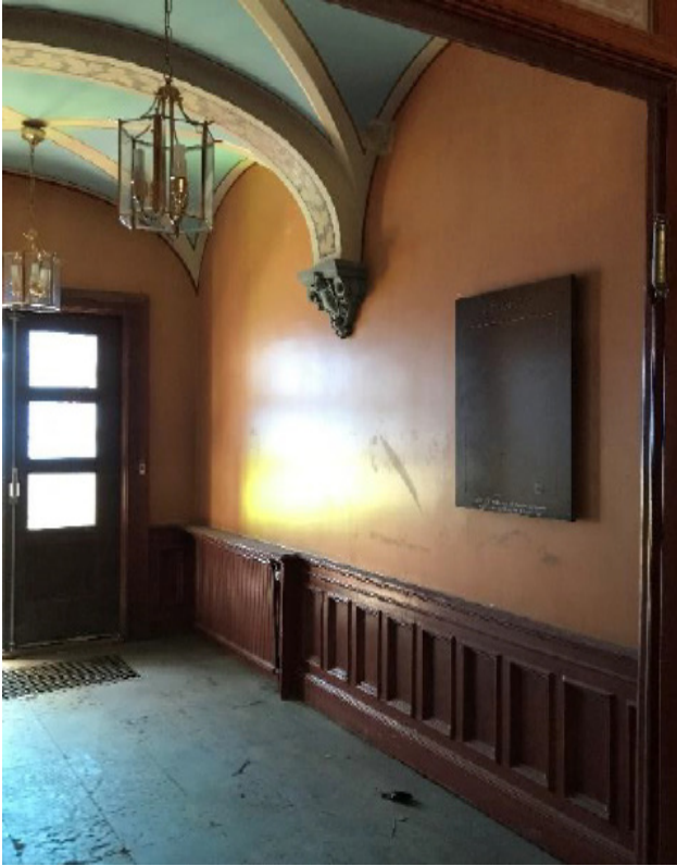
Inre och yttre entrérum mot Jakobsbergsgatan, som tillsynes är oskadat förutom brandrök. (AIX)
