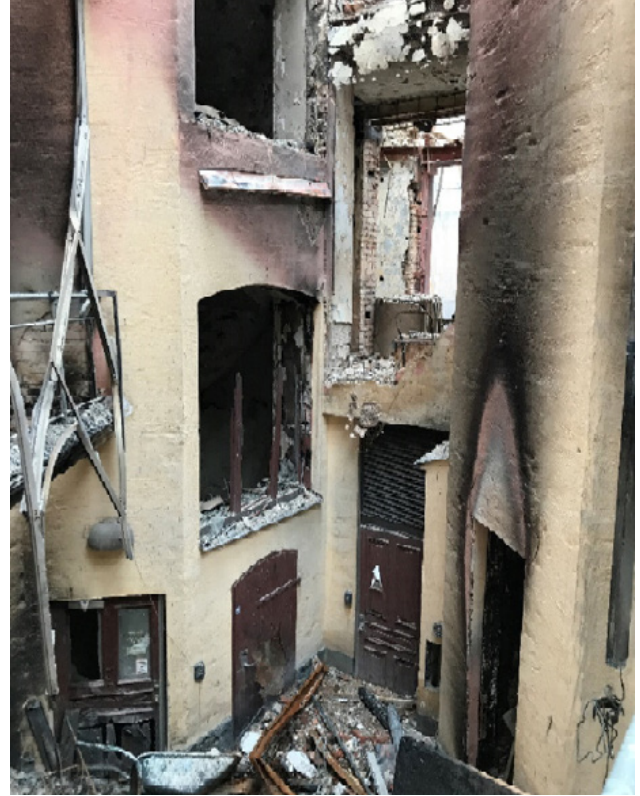
Fönsteröppningar mot trapphuset mot Biblioteksgatan. (AIX)
