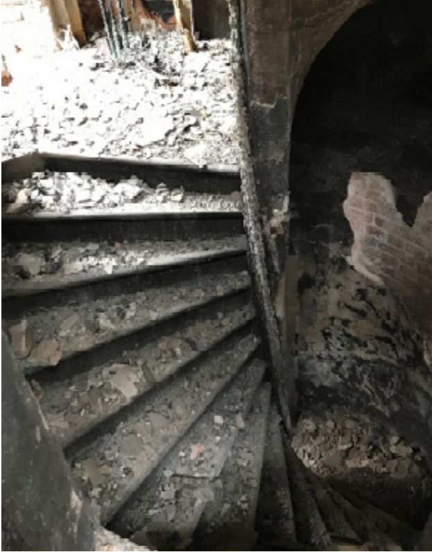
Trapphus mot gården. (AIX)
