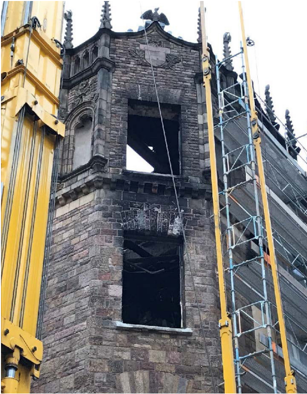
Hörnet Biblioteksgatan och Jakobsbergsgatan i januari 2018. (AIX)
