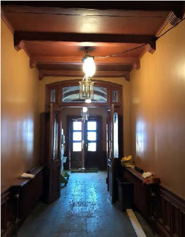
Trapphuset mot Jakobsbergsgatan har inga synliga skador i bottenvåningen men fukt- och rökskadorna blir värre högre upp i huset. (AIX)
