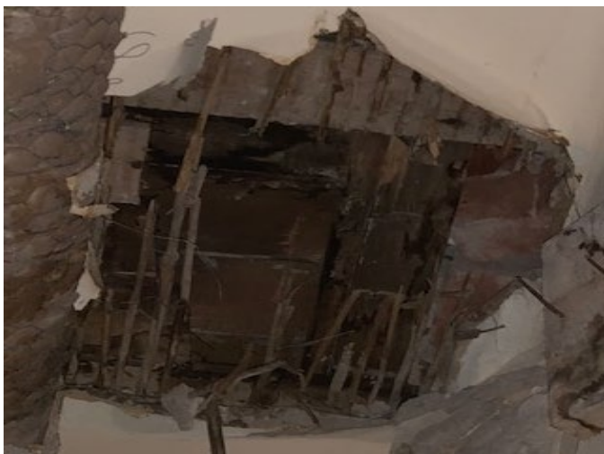
Foto 3: Innertak, bjälklagsfyllning
