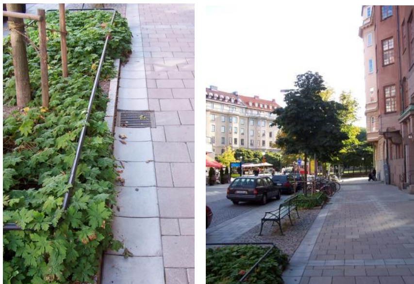
Figur 8. Vänstra bilden visar en vanlig rännstensbrunn som leds till skelettjorden intill. Högra bilden visar träd planerade i skelettjord på Erik Dahlbergsallén (Bildkälla: Stockholm vatten och avfall)
