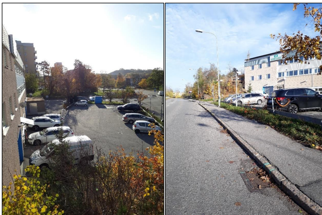
Figur 13. Byggnad och parkering avvattnas till dagvattenledning i Vårholmsbackarna/Stångholmsbacken
