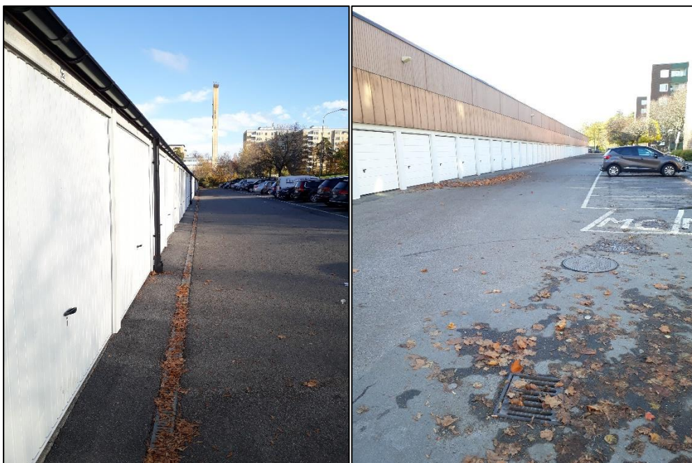
Figur 11. Parkeringsyta och tak avvattnas till markrännan (vänster bild) och parkeringsyta i norr avvattnas till rännstensbrunnar (höger bild)
