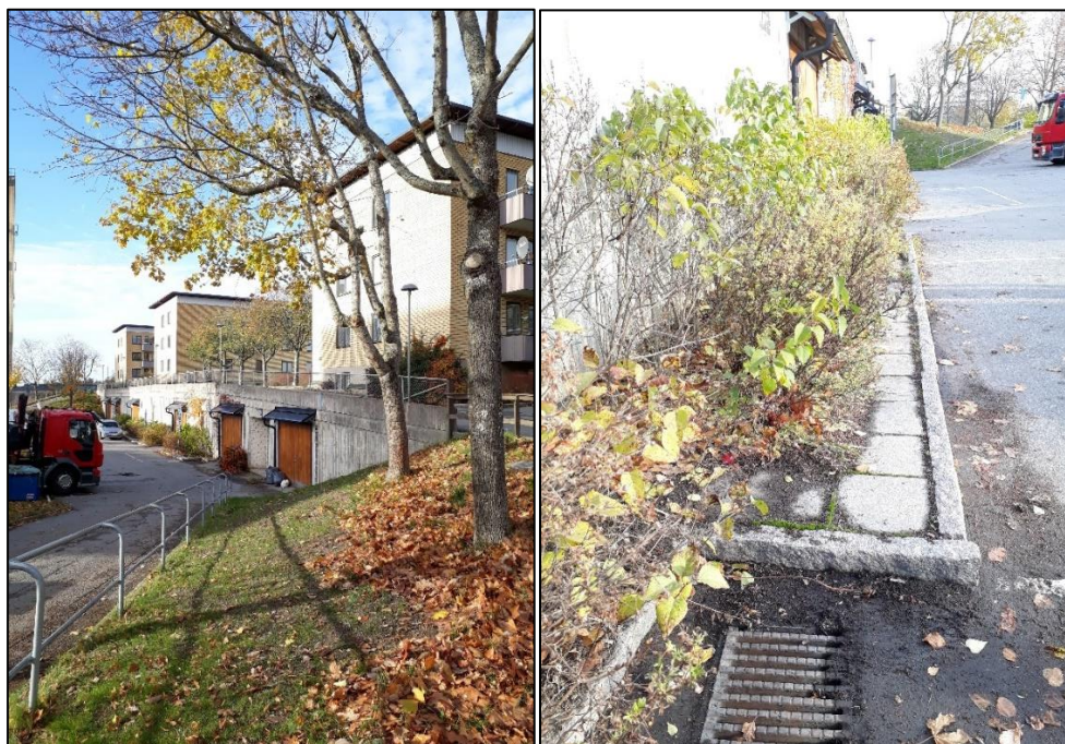
Figur 14. Garage under asfalterad väg, rännstensbrunn intill garage.
