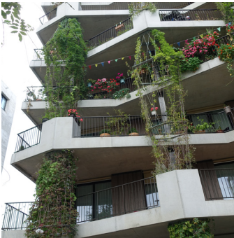
Integrerade balkonglådor som möjliggör fasadgrönska.
