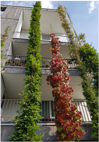
Inskjutna balkonger med plats för fasadgrönska.
