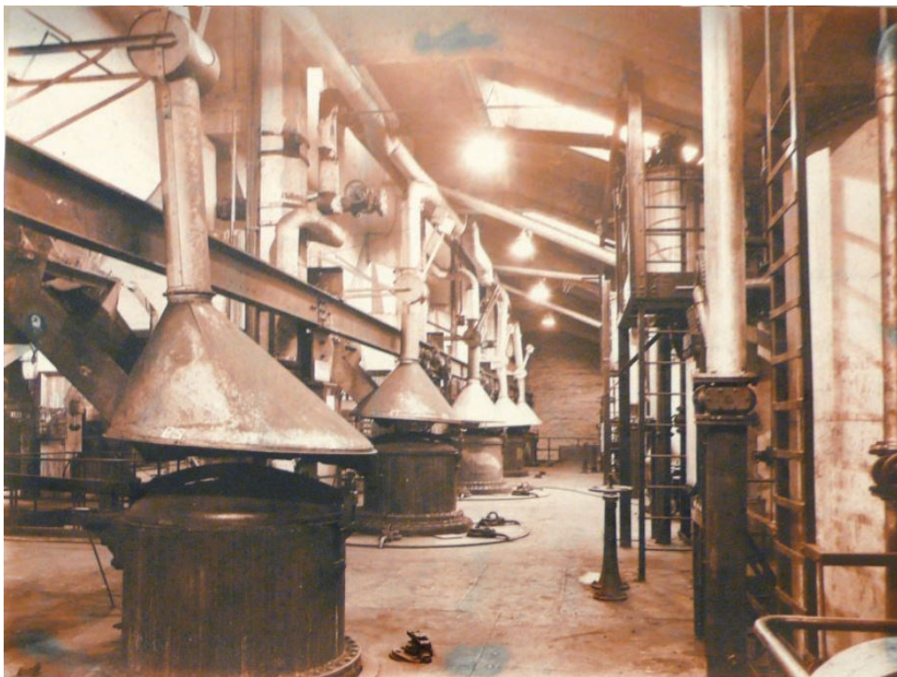
Bild 24: Foto av östra delen av hus 24 med väggen som avdelar mot hus 25 i bakgrunden. I bild syns generatorgasugnarna med kolfickor i byggnadens mitt. I taket syns takfönstren. Foto efter 1916 då generatorgasugnarna och kolfickorna installerades. Källa: Gasverket i Värtan.
