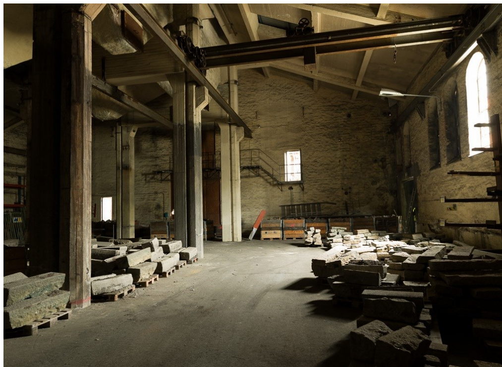
Bild 25: Foto av västra delen av hus 24 med väggen som avdelar mot hus 25 i bakgrunden, år 2015. Nivån för plattformen kan ses vid den kvarvarande balken mellan pelarna under koksäckarna till vänster i bild.
