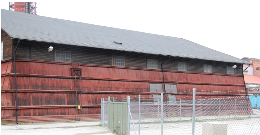
Bild 17: Fasad mot sydost.
