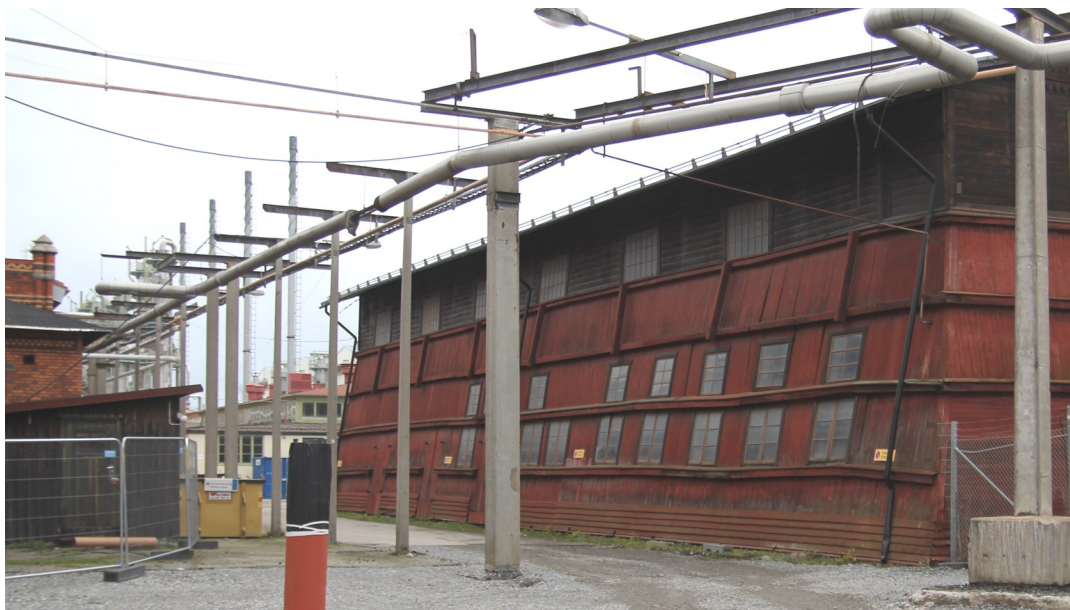
Bild 21: Fasad mot nordväst sett från väster.
