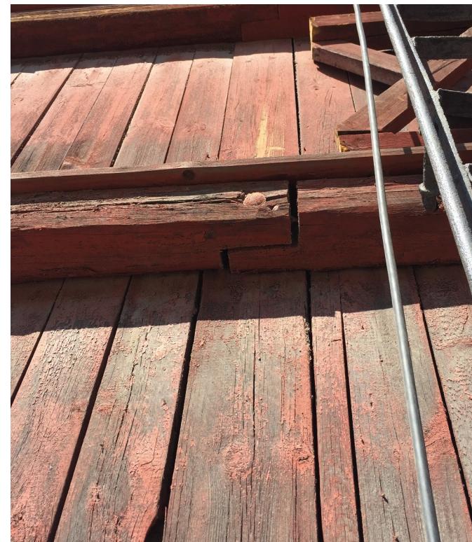
Bild 42: Skärmarna är infästa med vagnsbultar.
