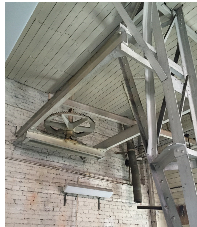
Ovan: Bild 49: Ursprunglig lyftanordning i byggnadens västra del, förankrad i den invändiga tegelmuren.
