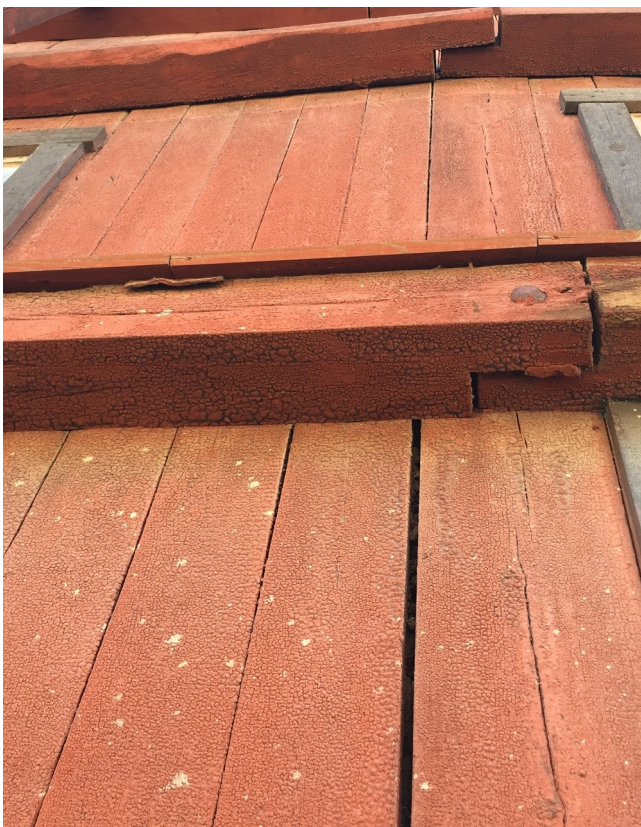
Bild 41: Karaktäristisk krackelering av rödfärg infuserad med linolja.
